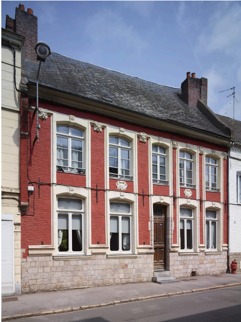
Façade principale, vue orientée est/ouest.
