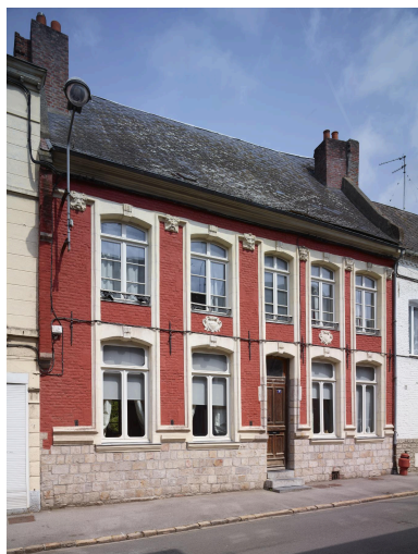
Façade principale, vue orientée est/ouest. Phot. Pierre Thibaut IVR32_20245900151NUCA
