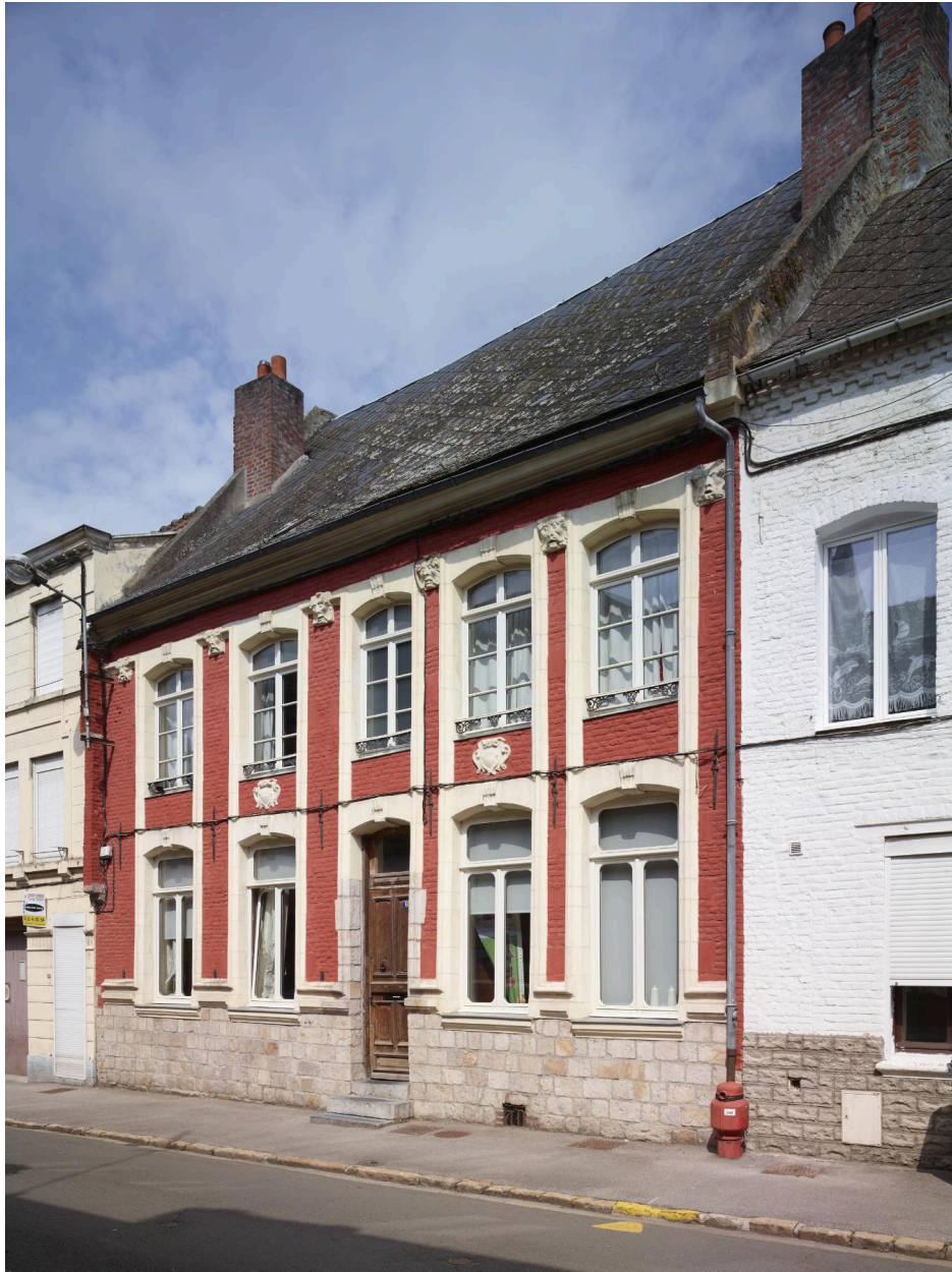
Façade principale, vue orientée ouest/est.
