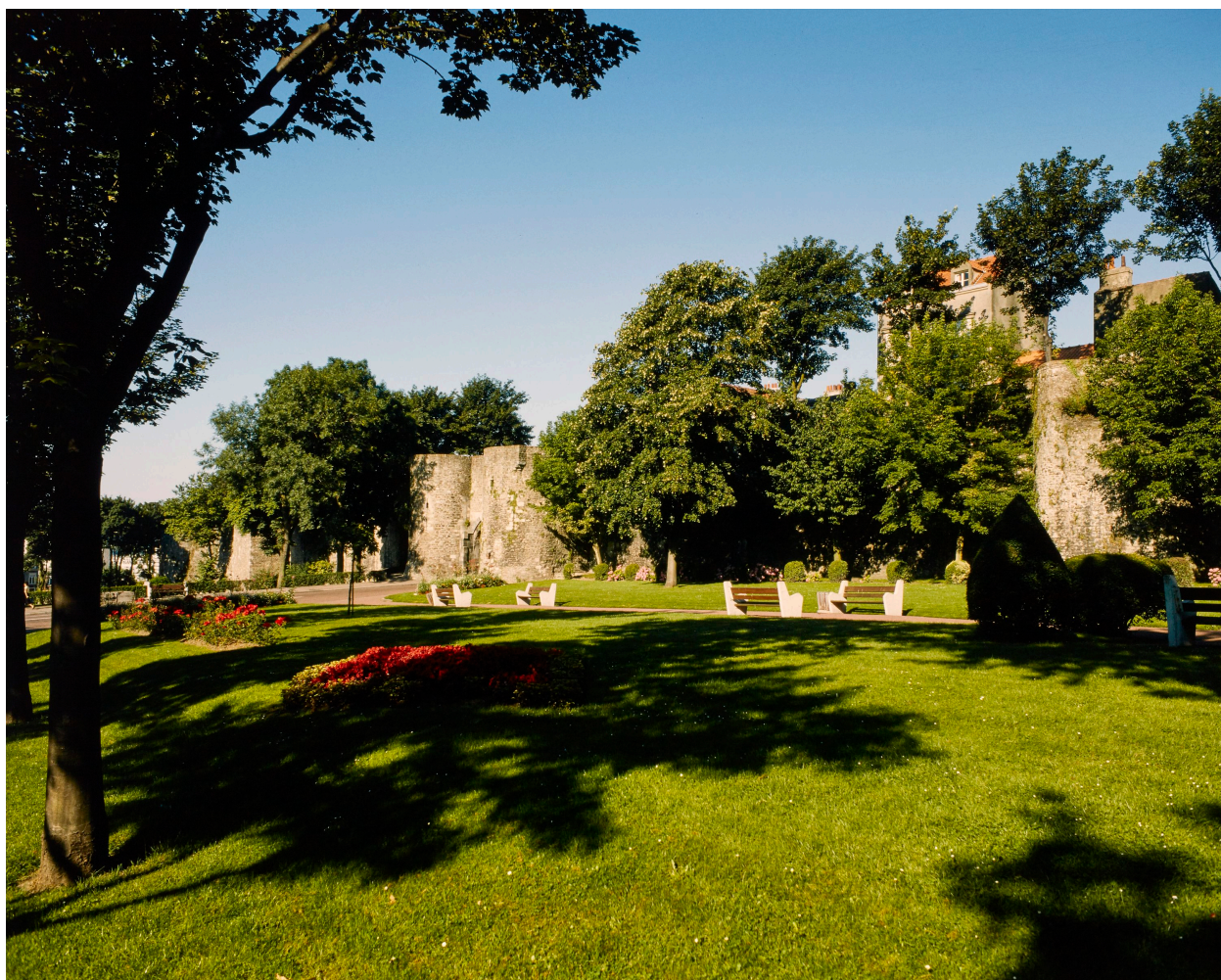
Vue sur boulevard, vue générale sud-est.
