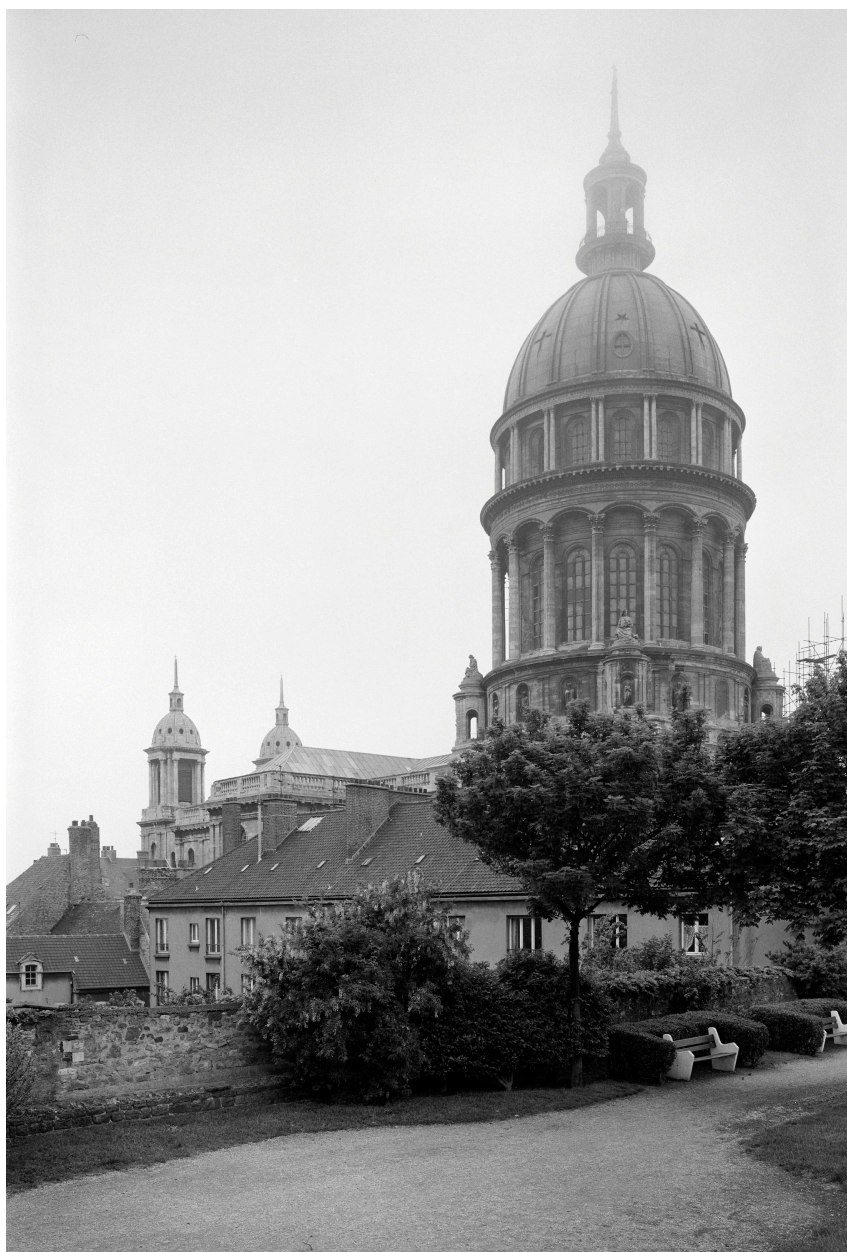
Vue sur remparts, côté nord-est, près de la parcelle n° 45.
