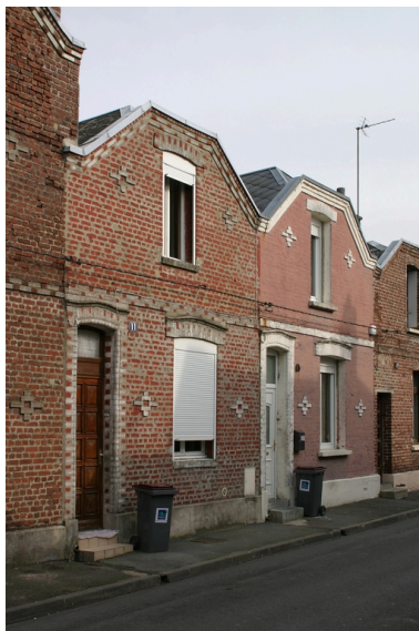
Deux logements. Phot. Frédéric Pillet IVR22_20060205099NUCA
