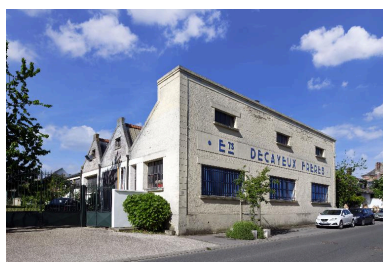
Façade antérieure de l'usine depuis la rue Jules Guesde.
