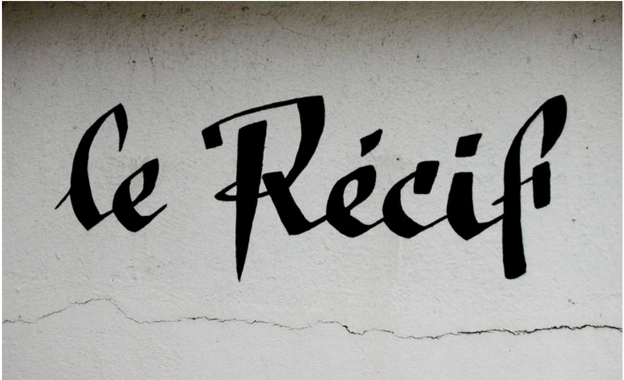
Détail de l'appellation peinte en façade postérieure.
