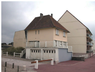
Vue de trois-quarts depuis la digue. Phot. Elisabeth Justome IVR22_20058003269NUCA
