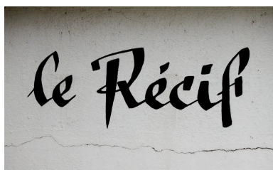
Détail de l'appellation peinte en façade postérieure. Phot. Elisabeth Justome IVR22_20058003271NUCA
