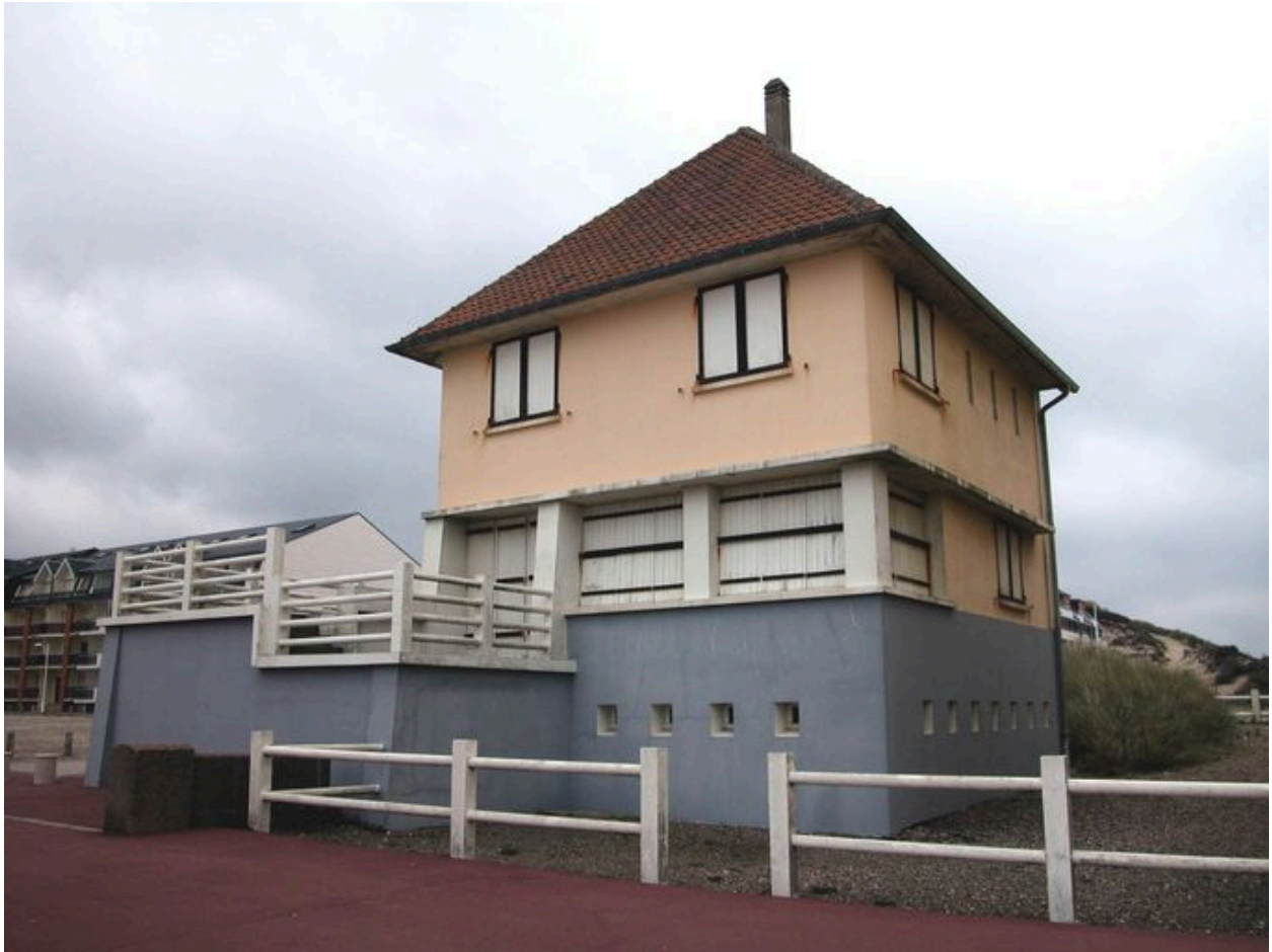
Vue d'ensemble depuis la digue.
