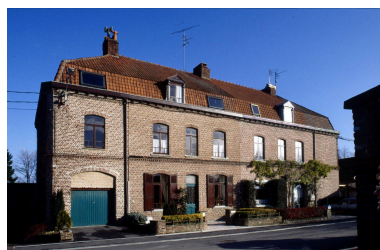
Logements de contremaîtres (bâtiment I). Phot. Thierry Petitberghien IVR31_19965901545ZA
