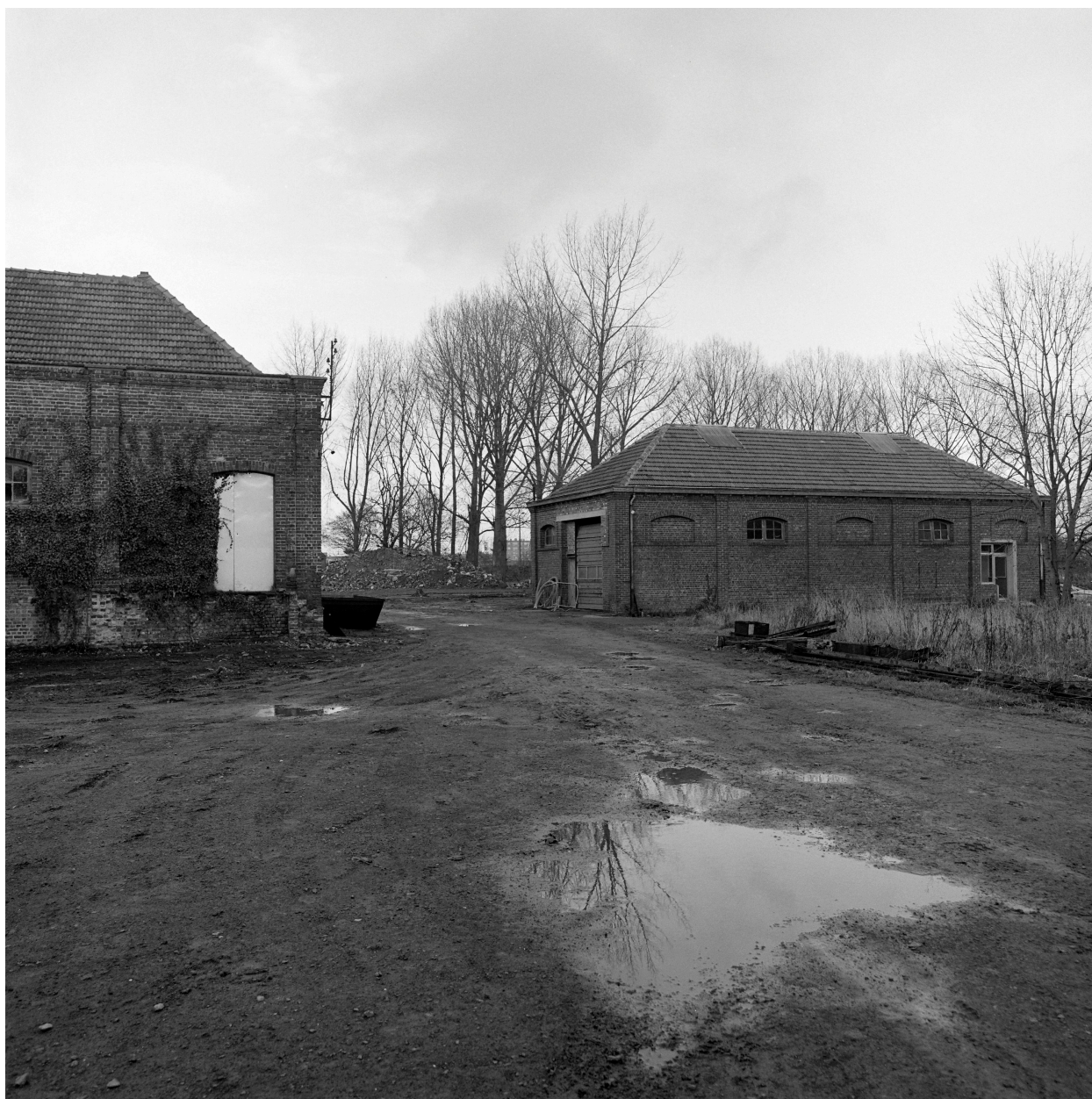
Entrepôt industriel (G), vue prise vers l'est.
