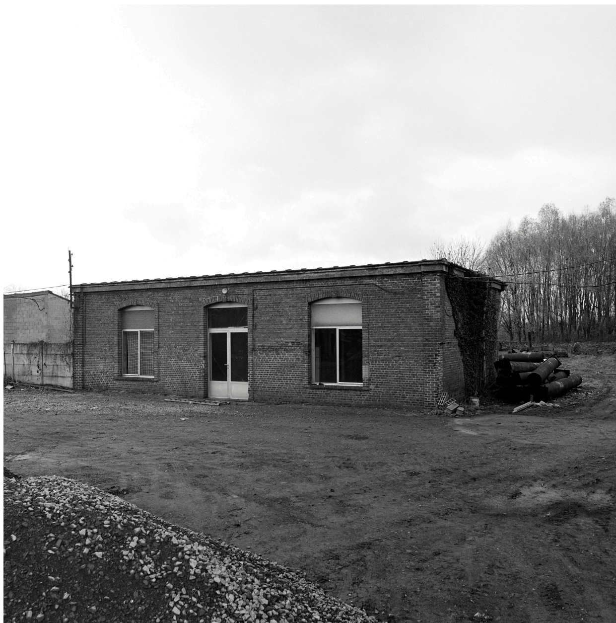
Entrepôt industriel (bâtiment F).
