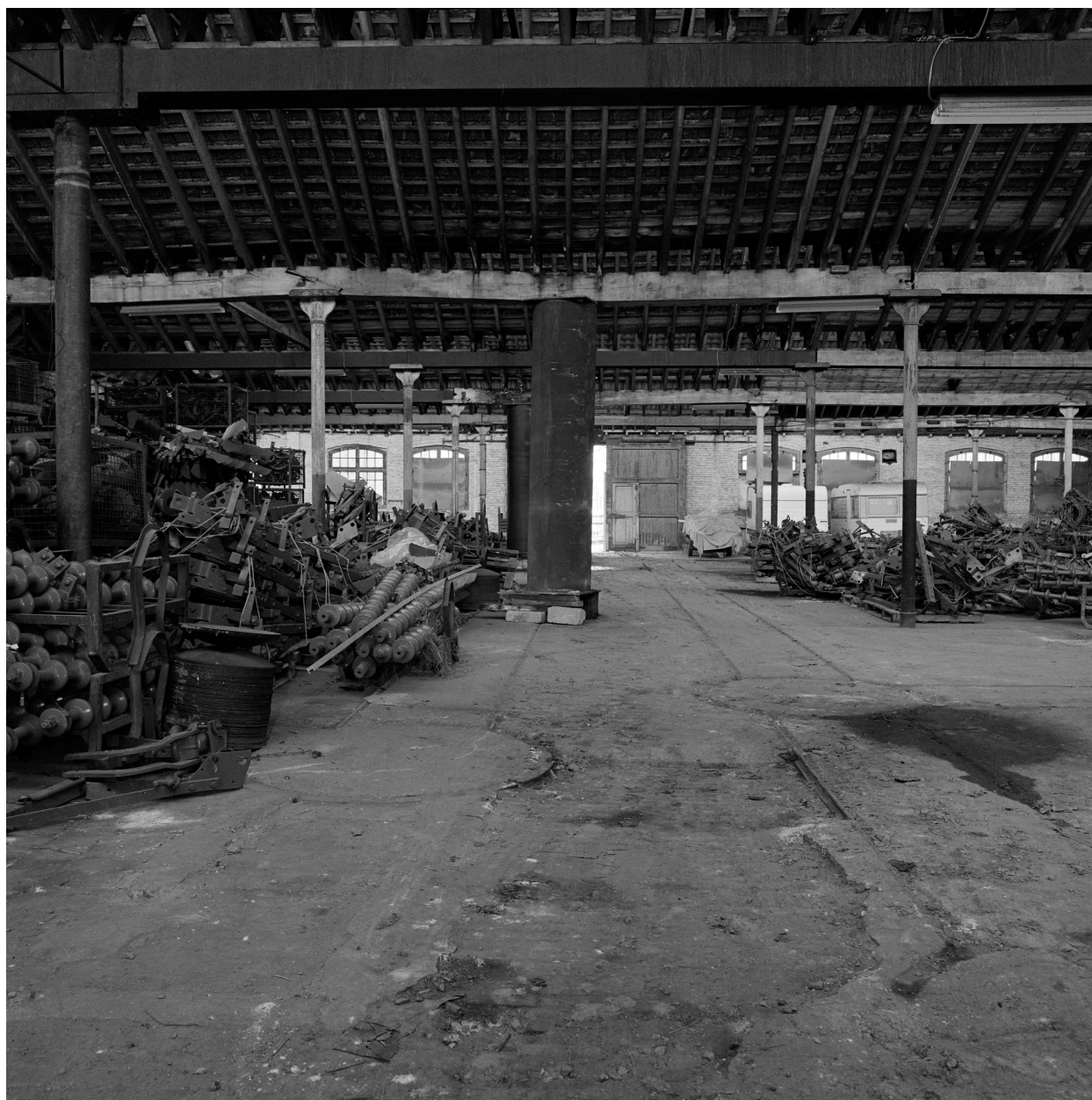
Atelier de blanchiment (E). Au centre un étau de fortune, au sol les anciens rails et rotondes à wagonnets.
