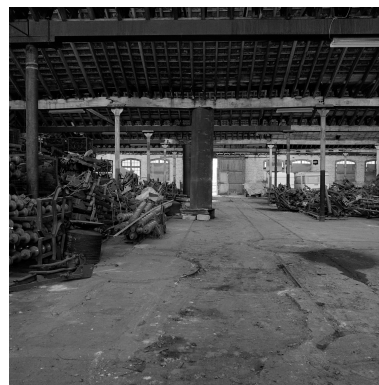
Atelier de blanchiment (E). Au centre un étai de fortune, au sol les anciens rails et rotondes à wagonnets. Phot. Olivier Marlard IVR31_19885902214X
