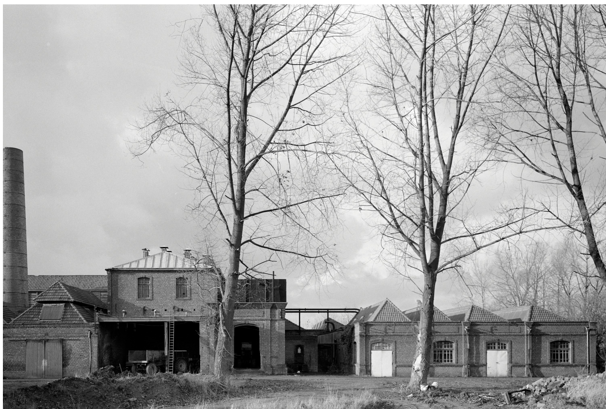
Vue d'ensemble depuis le sud-est. De gauche à droite, l'atelier de débouillissage (C), la salle des machines surmontée à gauche d'une pièce de séchage à feu nu (D). À l'extrême droite, l'atelier de blanchiment (E).
