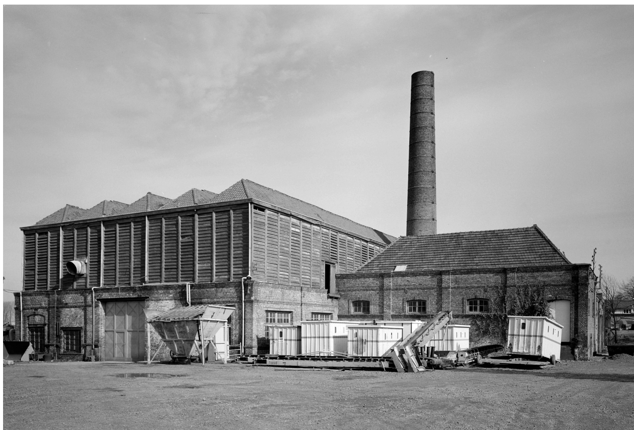
Vue d'ensemble vers le nord-est. À droite, l'atelier de crémage (A') et à gauche, au premier étage, la pièce de séchage en bois (B).
