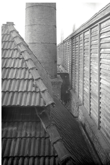
Atelier de débouillissage (C) : détail de la couverture. À droite, l'abat-vent de la pièce de séchage (B) en position fermée.
