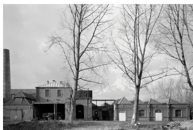
Vue d'ensemble depuis le sud-est. De gauche à droite, l'atelier de débouillissage (C), la salle des machines surmontée à gauche d'une pièce de séchage à feu nu (D). À l'extrême droite, l'atelier de blanchiment (E). Phot. Olivier Marlard IVR31_19885902224X
