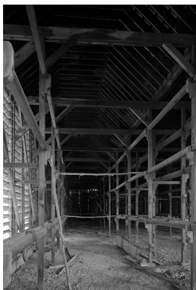
Pièce de séchage (B) au premier étage : système de suspension des écheveaux de lin et abat-vent à gauche.
