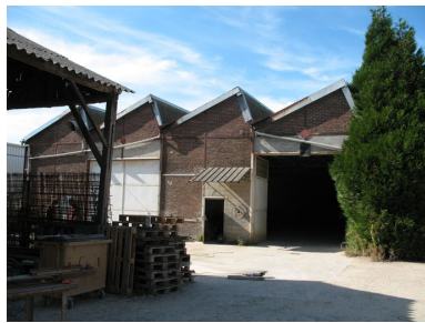
Anciens ateliers de vernissage et de vérification des fûts étanches. Phot. Clarisse Lorieux IVR22_20096005146NUCA
