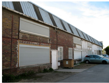
Façade est de l'ancien atelier des fûts étanches. Phot. Clarisse Lorieux IVR22_20096005147NUCA
