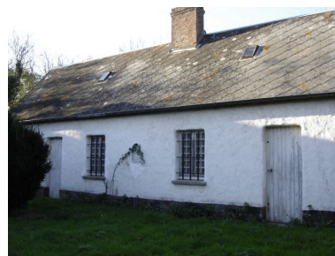
Vue du logis. Phot. Inès Guérin IVR22_20068005834NUCA
