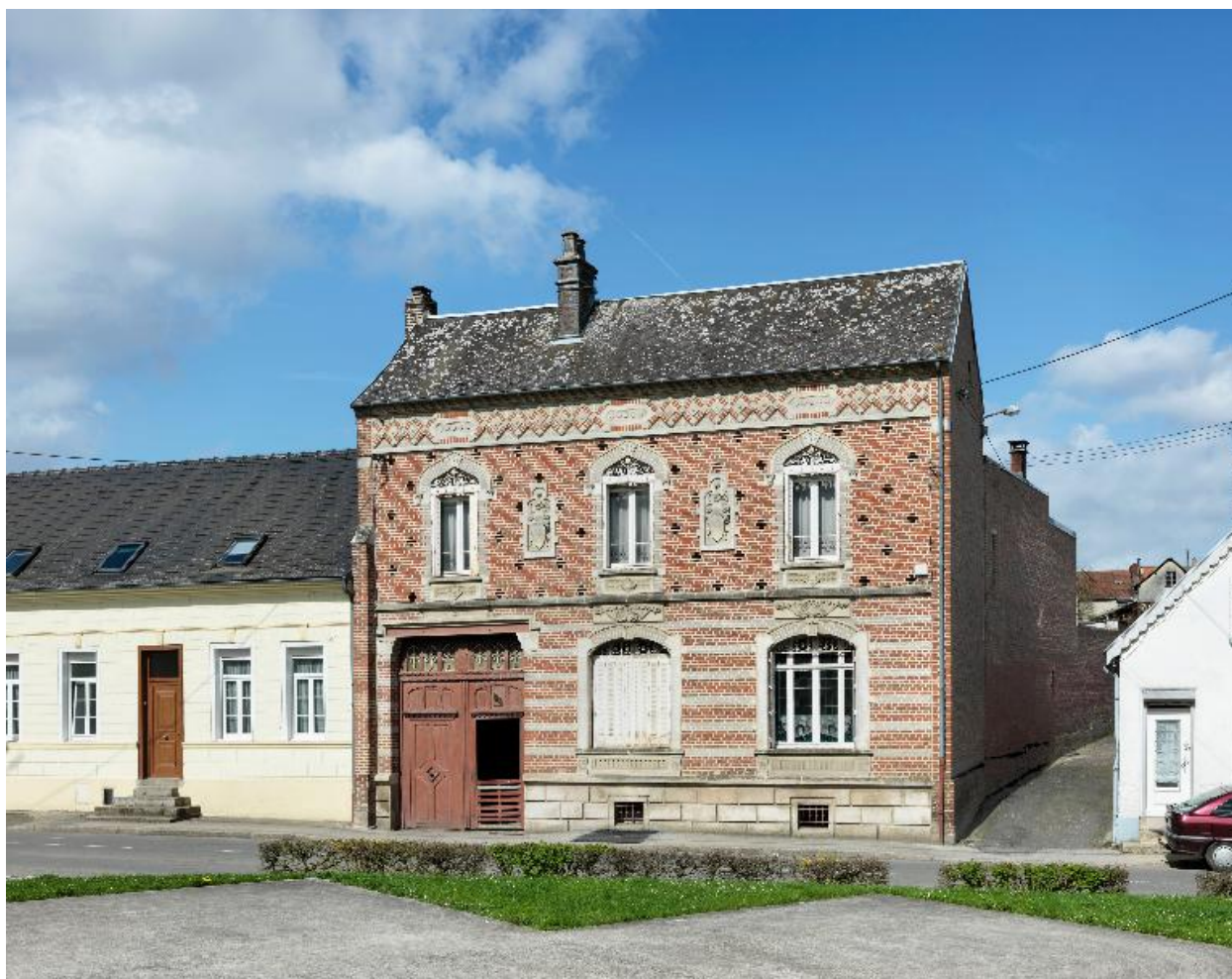
Vue d'ensemble de la façade sur rue.
