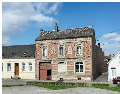
Vue d'ensemble de la façade sur rue.
