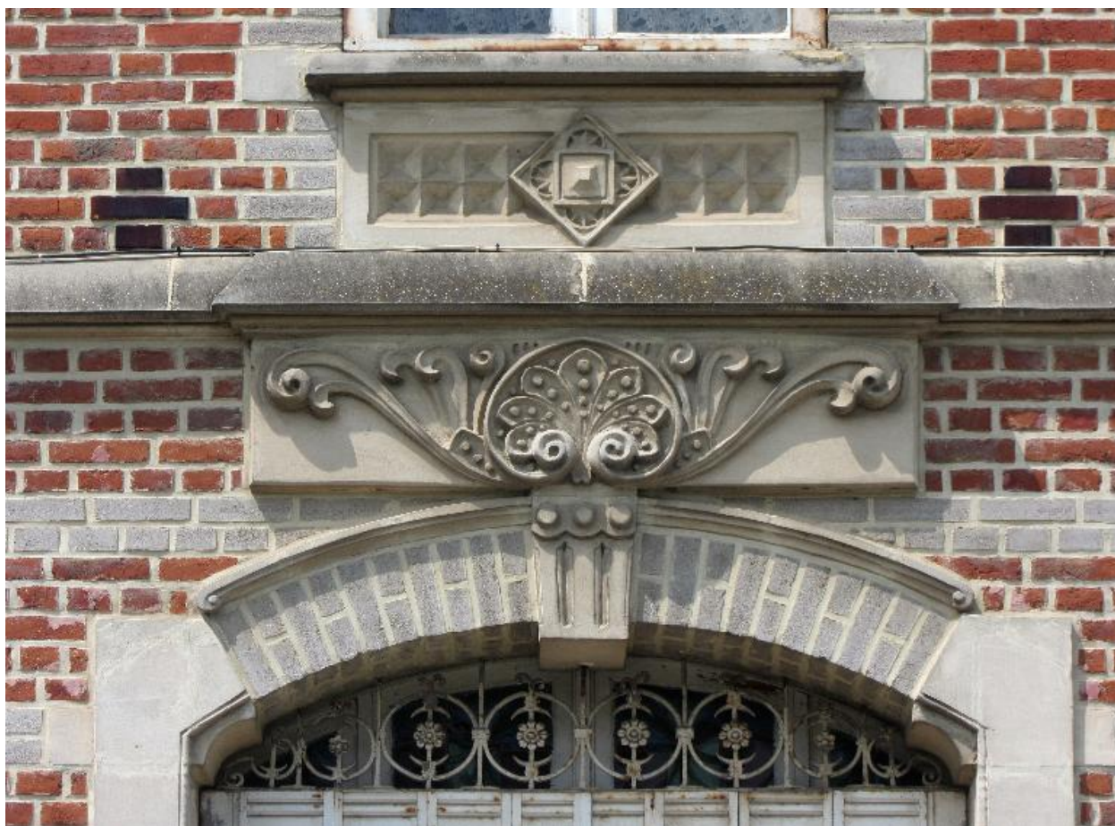
Détail de la table et de l'appui de fenêtre du premier étage.
