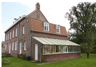
Pignon ouest et arrière du bâtiment. Phot. Delphine Volto Jourdan IVR32_20245903103NUCA
