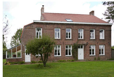
Façade sud, donnant sur le jardin. Phot. Delphine Volto Jourdan IVR32_20245903101NUCA
