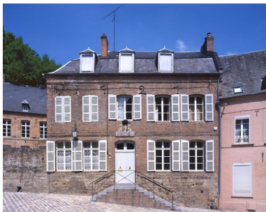
Vue de la façade sur rue de l'ancienne
