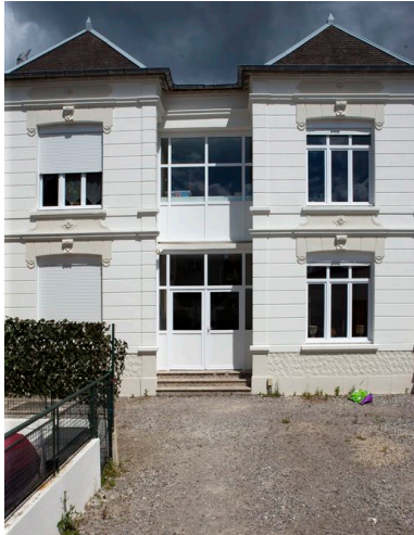
Vue générale du corps de bâtiment en fond de cour. Phot. Pierre Thibaut IVR31_20146202184NUCA
