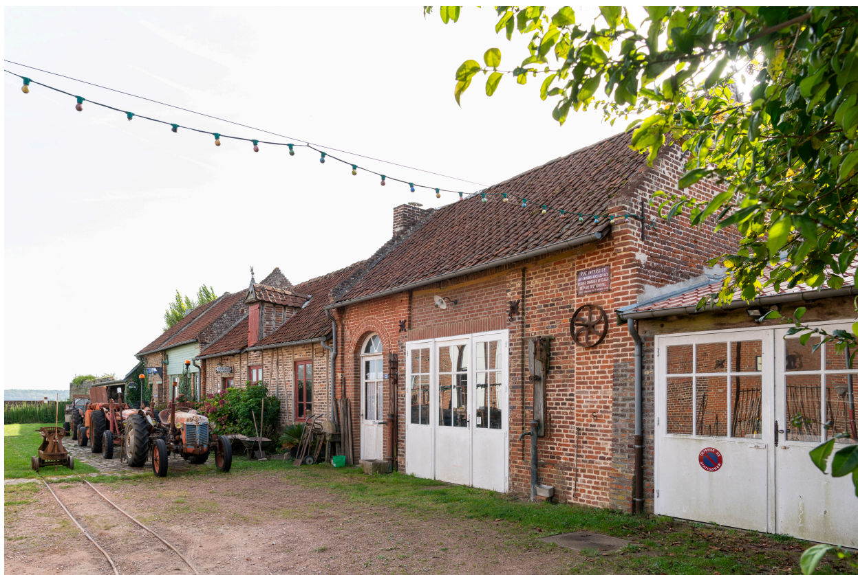
Alignement de bâtiments côté sud de la cour, vue depuis le nord-ouest.
