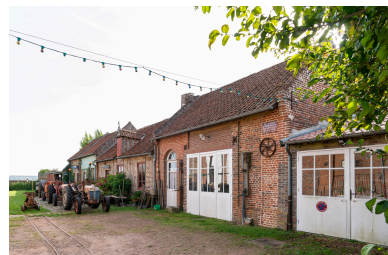
Alignement de bâtiments côté sud de la cour, vue depuis le nord-ouest. Phot. Marc Kérignard IVR32_20236001053NUCA
