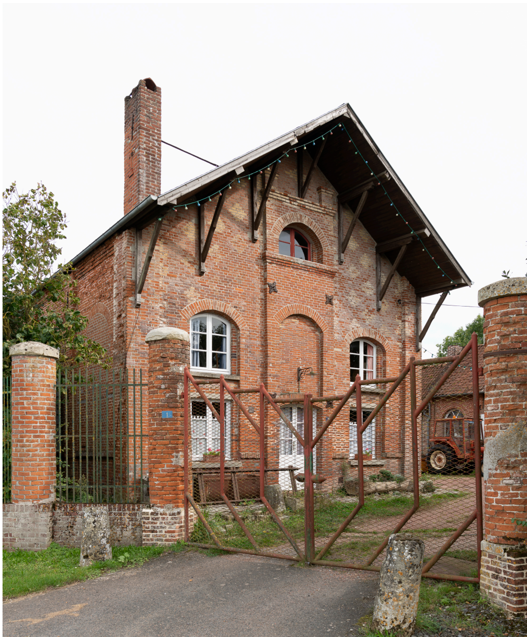
Entrée de l'ancien atelier depuis le nord-ouest.
