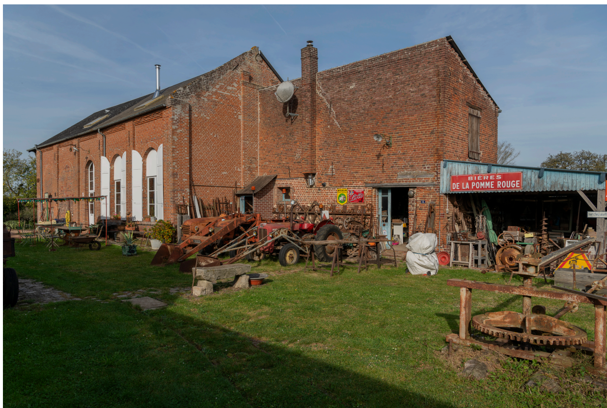
Ancien atelier et son annexe, vue depuis le sud-est.
