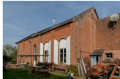
Ancien atelier, vue depuis le sud-est. Phot. Marc Kérignard IVR32_20236001049NUCA
