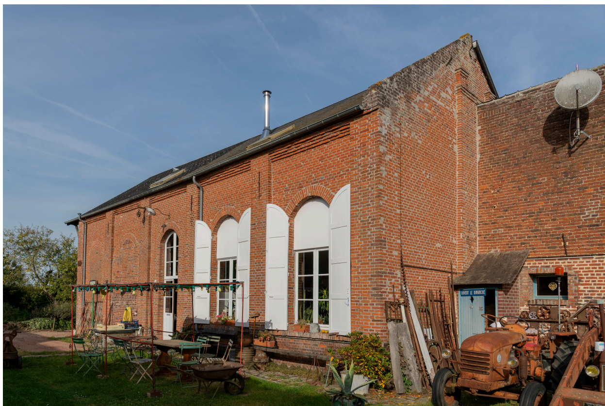
Ancien atelier, vue depuis le sud-est.
