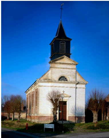
Vue générale. Phot. Irwin Leullier IVR22_19988000120VA
