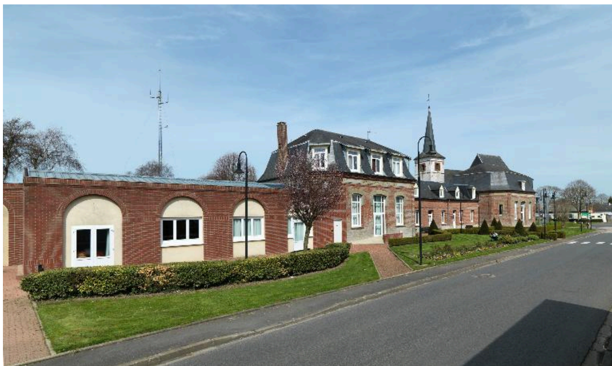
Vue générale depuis la rue Ferdinand-Buisson.
