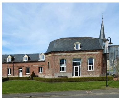
L'aile droite occupée par l'ancienne école de filles. Phot. Thierry Lefébure IVR22_20138000127NUC2A
