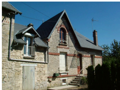
Vue générale. Phot. Inès Guérin IVR22_20030202497NUCA
