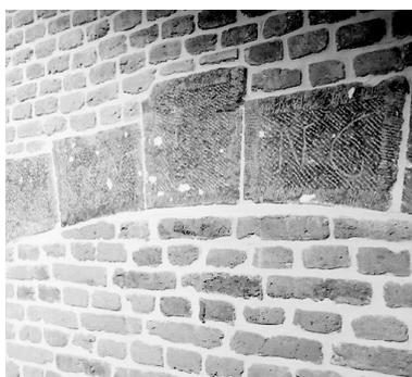
Intérieur : cage d'escalier, 4e volée, marques d'assemblage sur l'arc du mur de cage.
