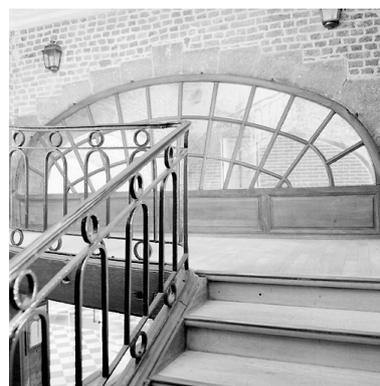
Intérieur : cage d'escalier, repos principal entre le rez-de-chaussée et le premier étage, baie en imposte ouvrant vers le passage cocher.
