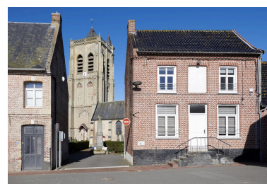
Vue du centre du village. Phot. Delphine Volto Jourdan IVR32_20255900612NUCA
