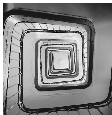
Cage d'escalier : vue générale en contre-plongée. Phot. Pierre Thibaut IVR31_20055900797X
