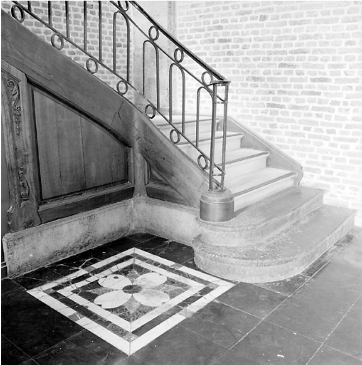
Cage d'escalier, rez-de-chaussée : départ de l'escalier.
