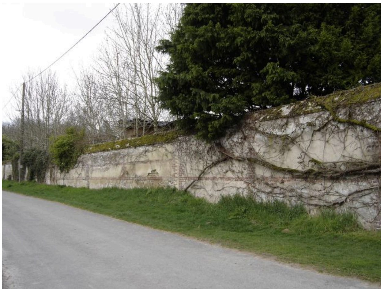
Vue du mur extérieur.
