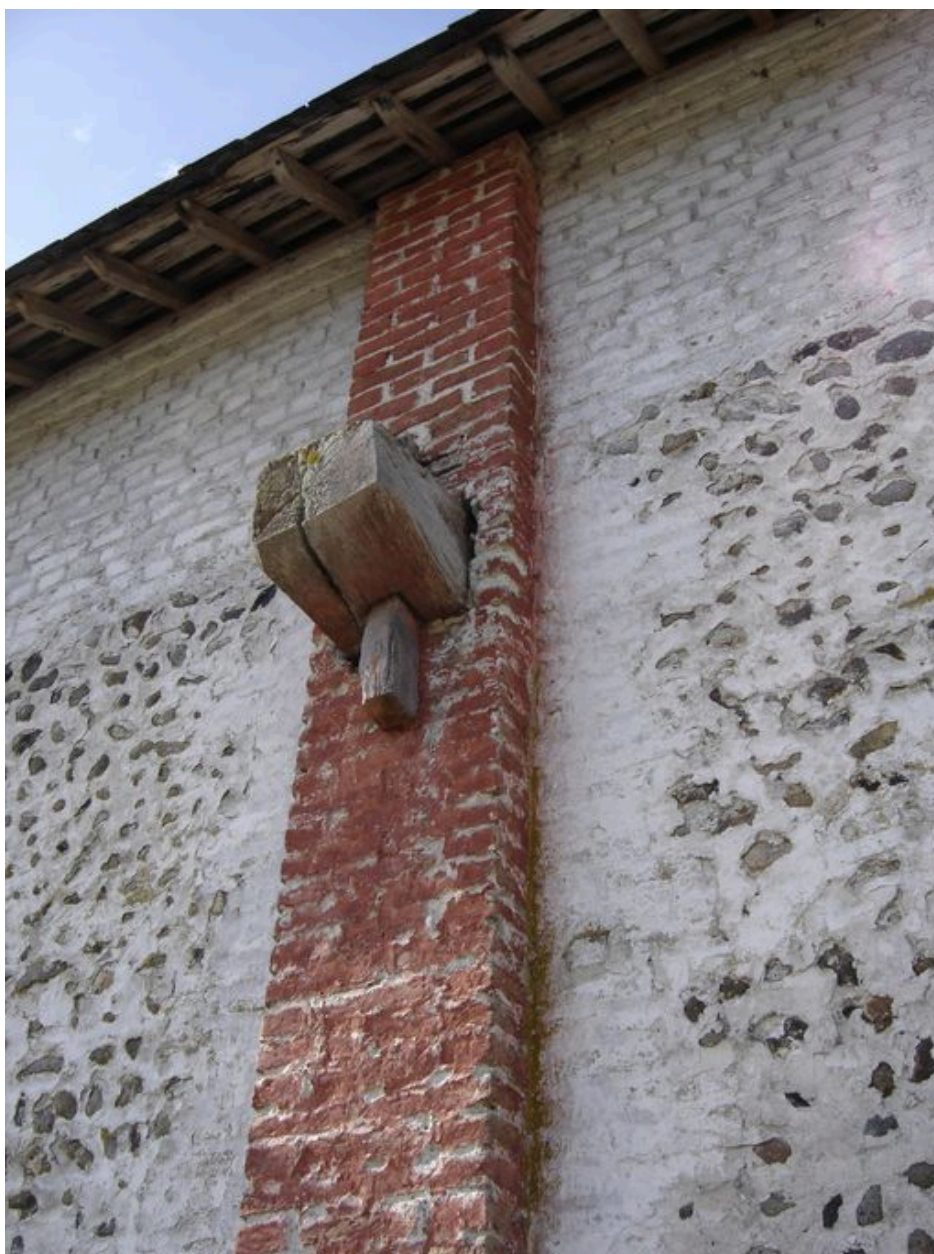
Détail d'un tenon d'ancrage.
