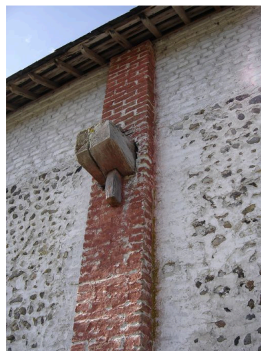
Détail d'un tenon d'ancrage. Phot. Inès Guérin IVR22_20058005142NUCA
