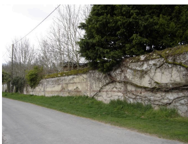
Vue du mur extérieur. Phot. Inès Guérin IVR22_20058005159NUCA
