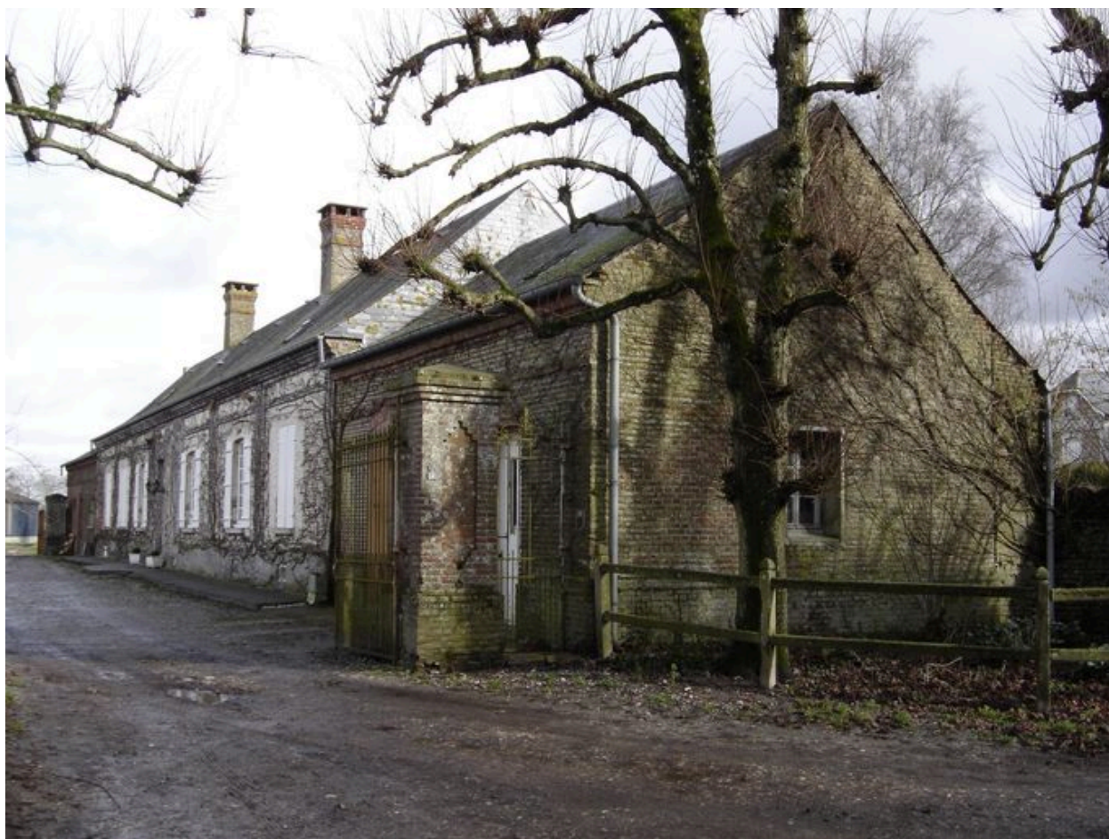
Vue du logis depuis l'entrée sud-ouest.
