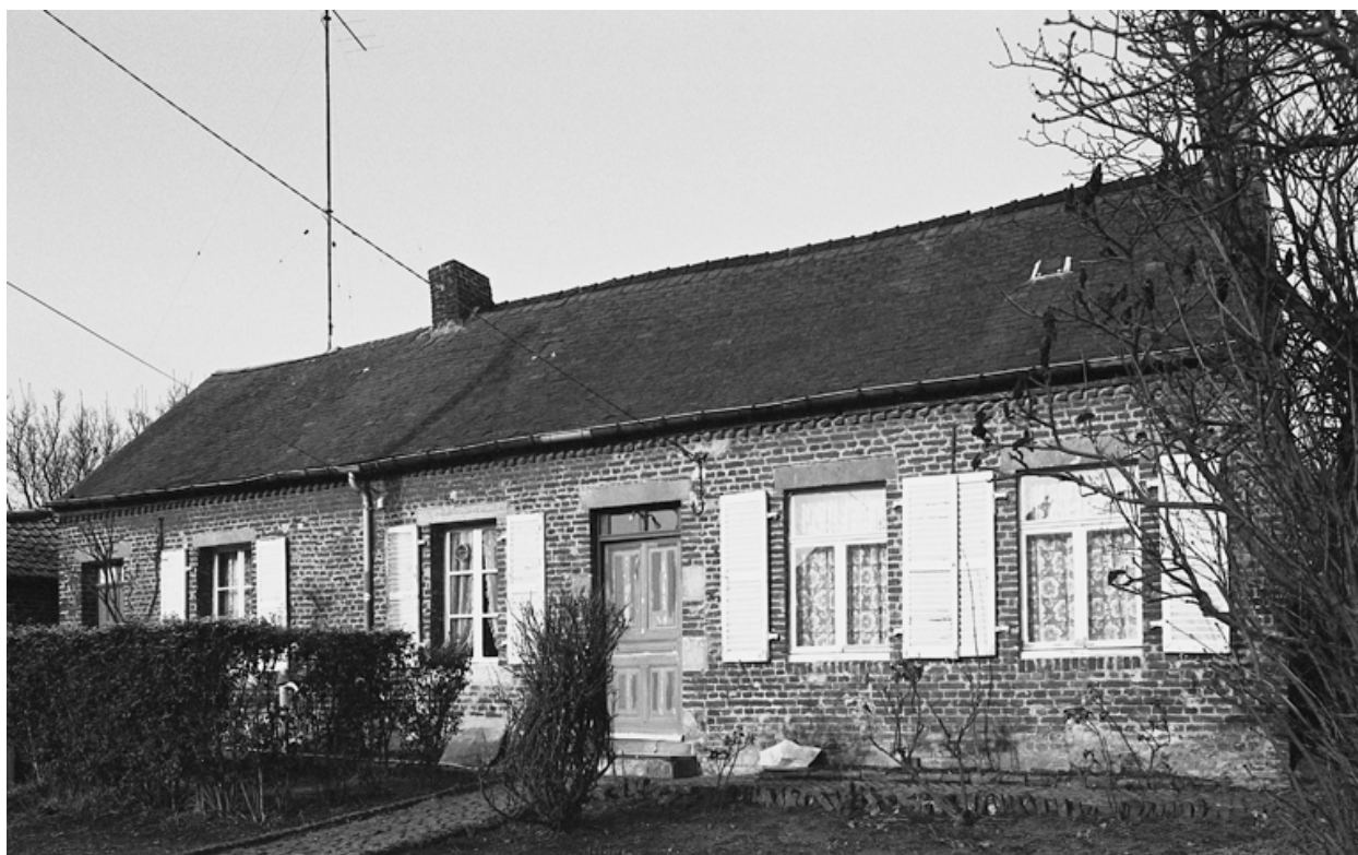
Vue d'ensemble de la façade.
