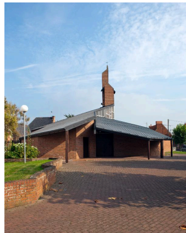
Vue de l'entrée. Phot. Pierre Thibaut IVR31_20145903210NUCA
