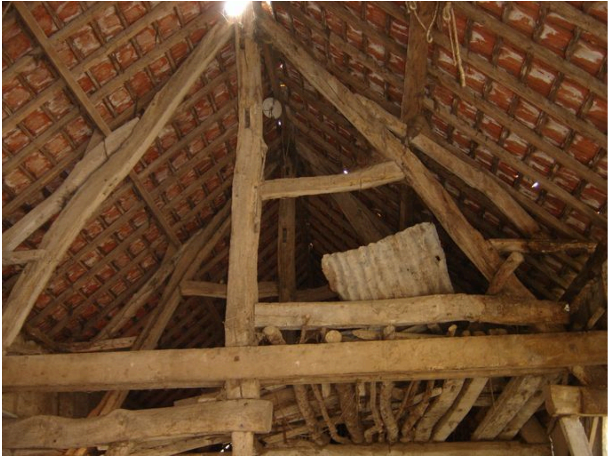
Vue détaillée d'une ferme de la grange.
