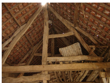
Vue détaillée d'une ferme de la grange. Phot. Inès Guérin IVR22_20068005845NUCA
