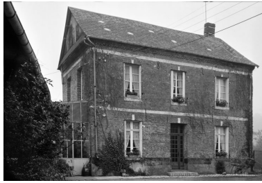
Logement patronal. Phot. Thierry Lefébure IVR22_19888001010V
