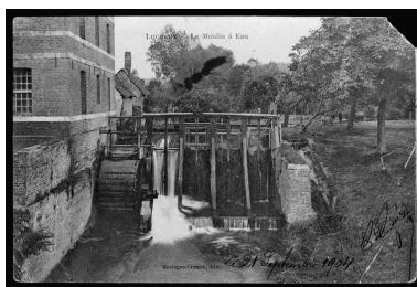
Le déversoir et la roue hydraulique, vers 1904 (coll. part.). Phot. Thierry Lefébure IVR22_19888001008XB
