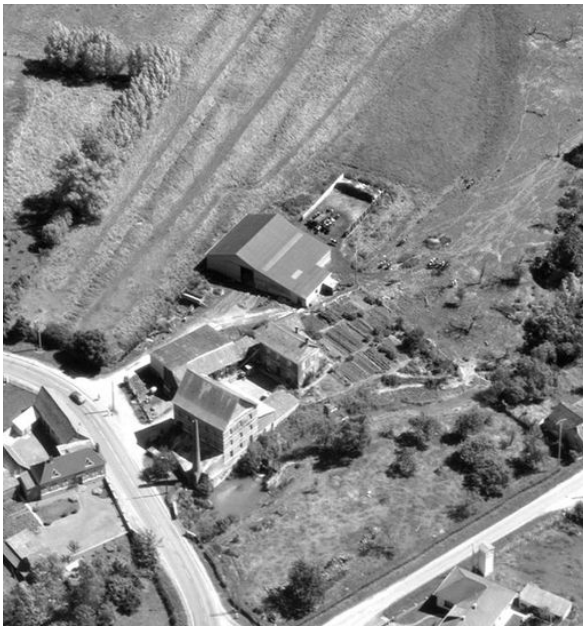
Vue aérienne, flanc sud.
