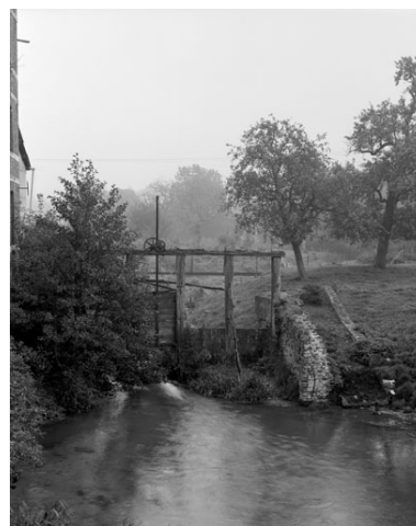
Vanne de décharge. Phot. Thierry Lefébure IVR22_19888001005X
