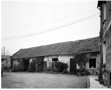
Remise (anciennes écuries). Phot. Thierry Lefébure IVR22_19888001003V
