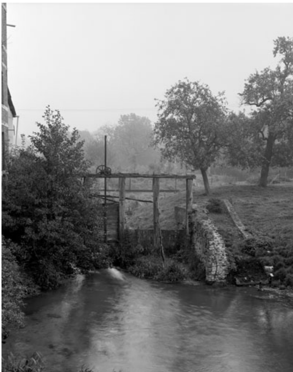
Vanne de décharge.
