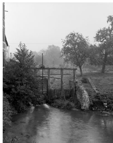
Vanne de décharge. Phot. Thierry Lefébure IVR22_19888001005X
