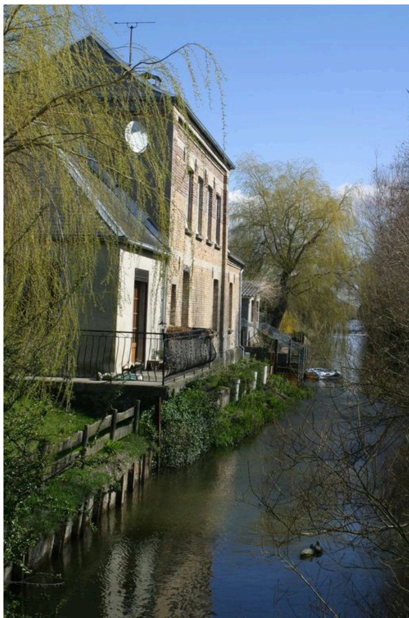
Vue postérieure du moulin à eau de Favières.
