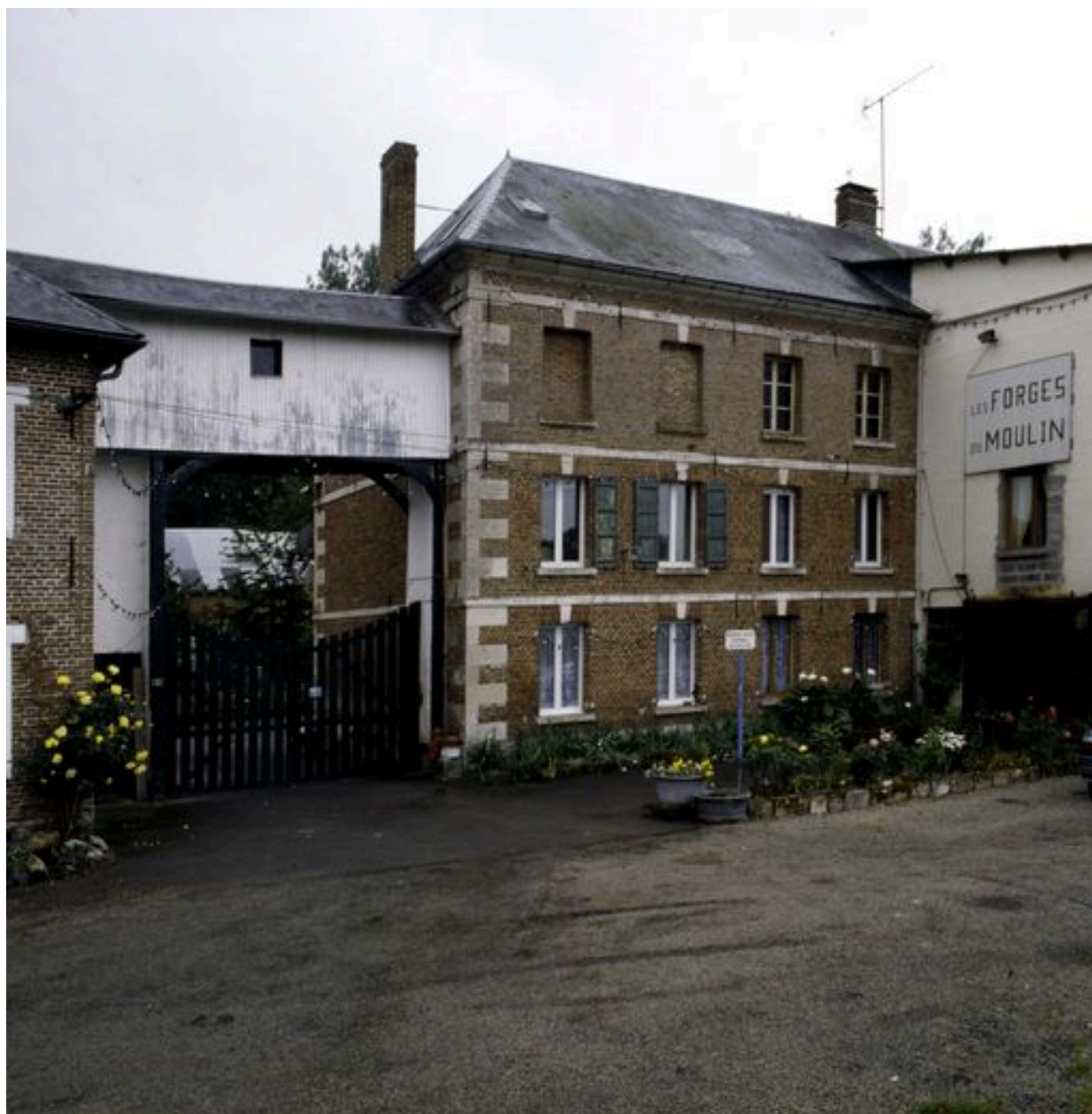
Vue partielle de la façade postérieure de la minoterie.
