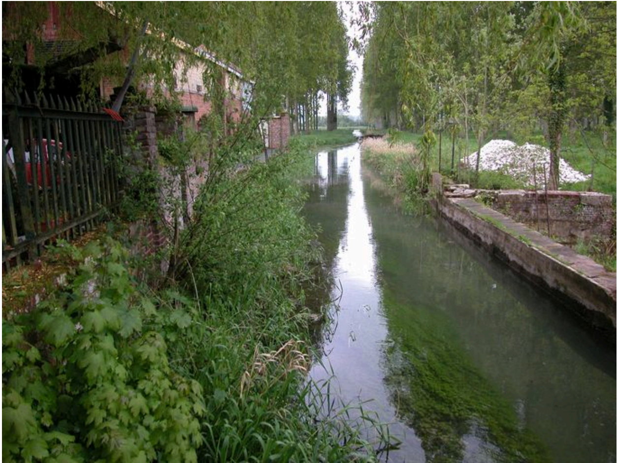
La Celle en amont du moulin des Prés, avec, à droite, le déversoir.
