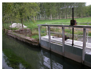
Le vannage de décharge et le déservoir du moulin. Phot. Bertrand Fournier IVR22_20056000789NUCA
