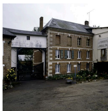
Vue partielle de la façade postérieure de la minoterie. Phot. Thierry Lefébure IVR22_20056000191XA
