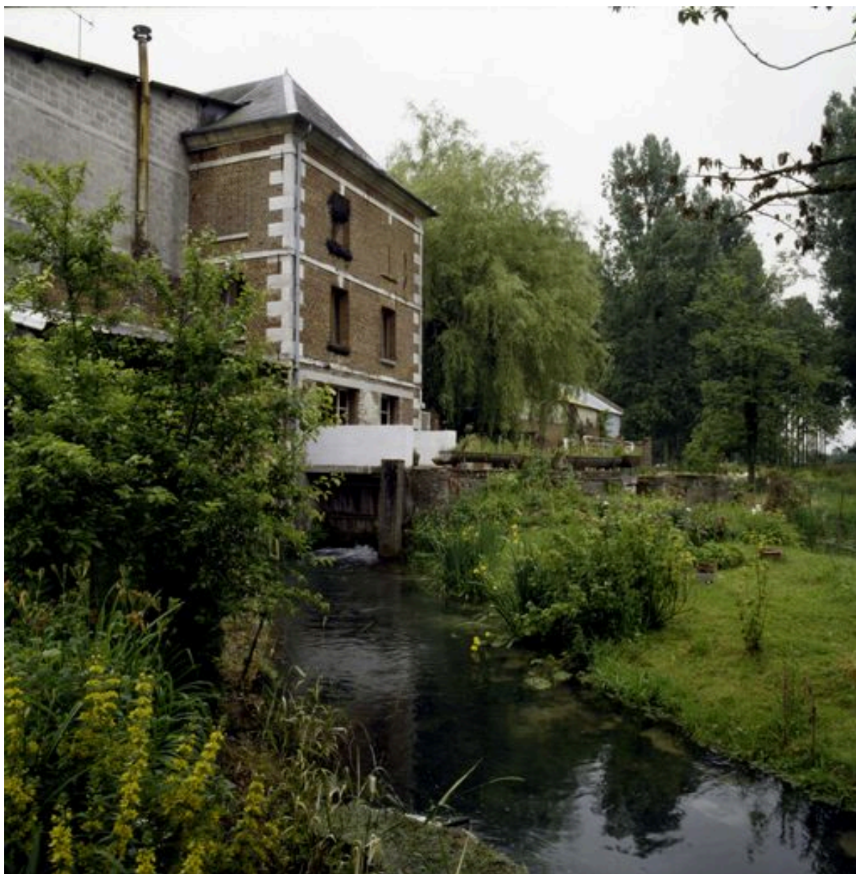
Pignon de la minoterie vers la rivière précédé de son déversoir.
