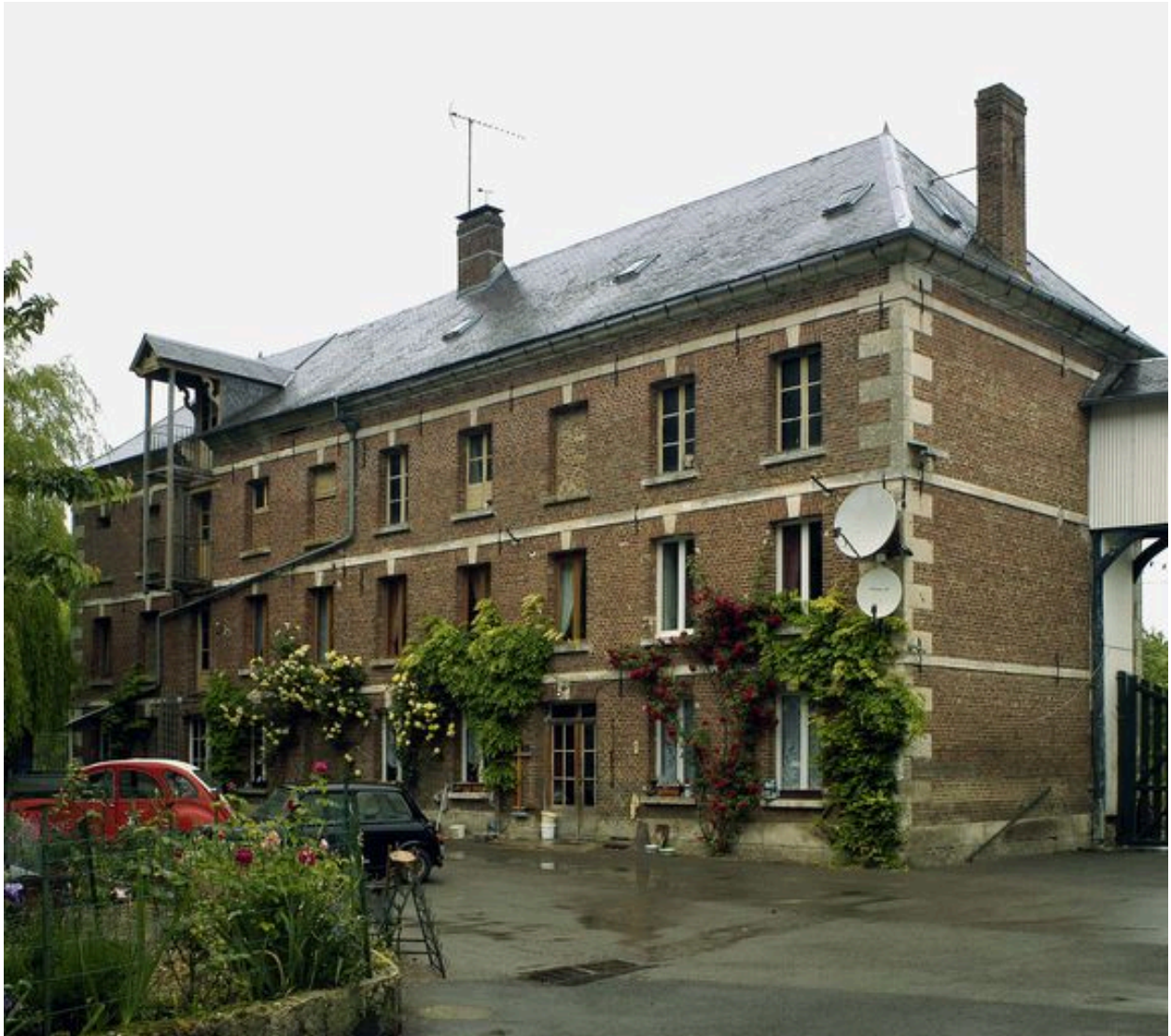
Façade sur cour de la minoterie.
