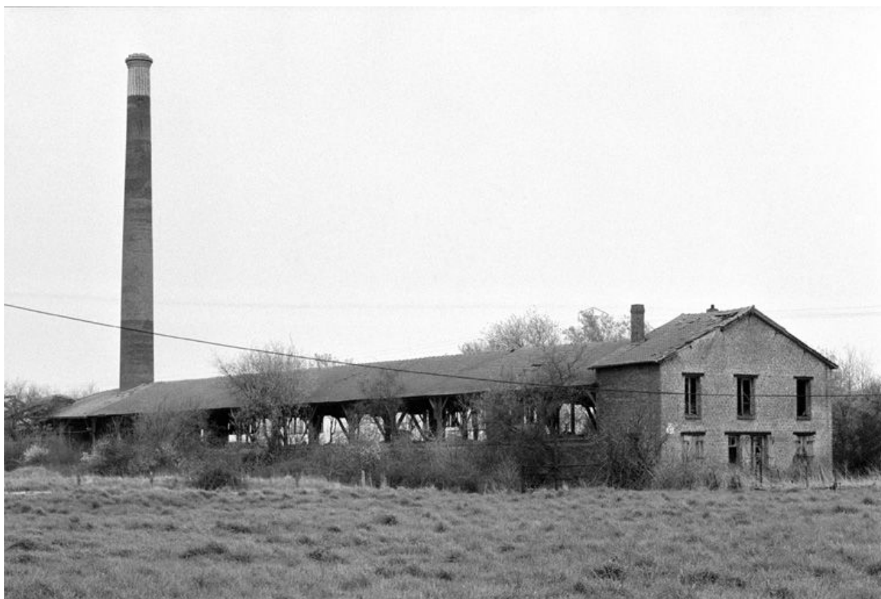
Atelier de fabrication, flanc sud-est.
