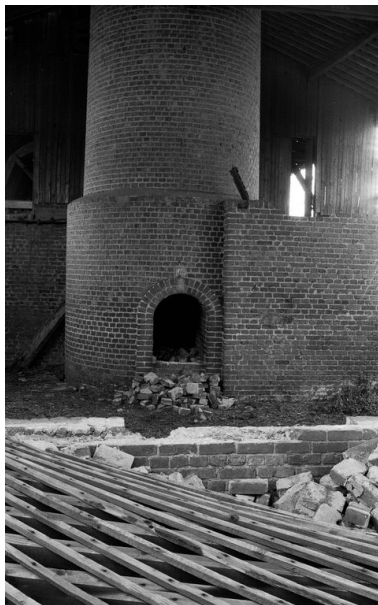
Cheminée d'usine. Phot. Francis Dubuc IVR22_19888000560Z
