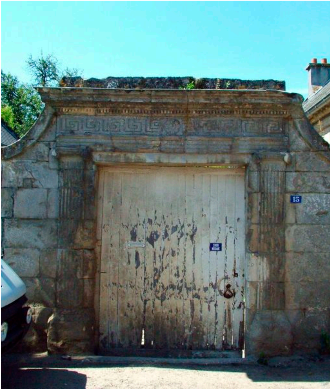
Portail, rue du Chauffour
