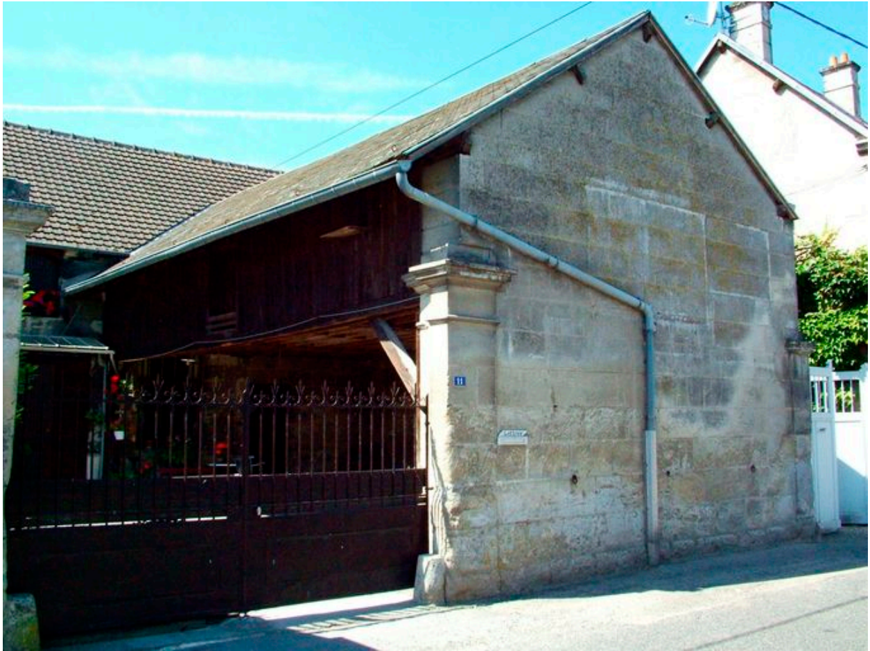
Vue d'une remise, rue du Chauffour
