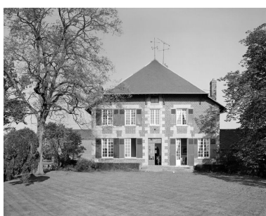
Logis. Elévation postérieure sur jardin. Phot. Jean-Michel Perrin IVR22_19846001332V
