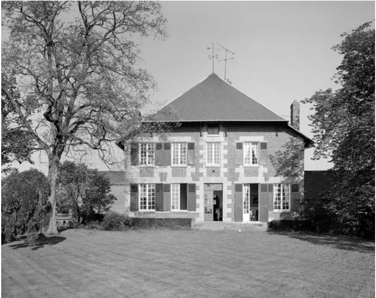
Logis. Elévation postérieure sur jardin.
