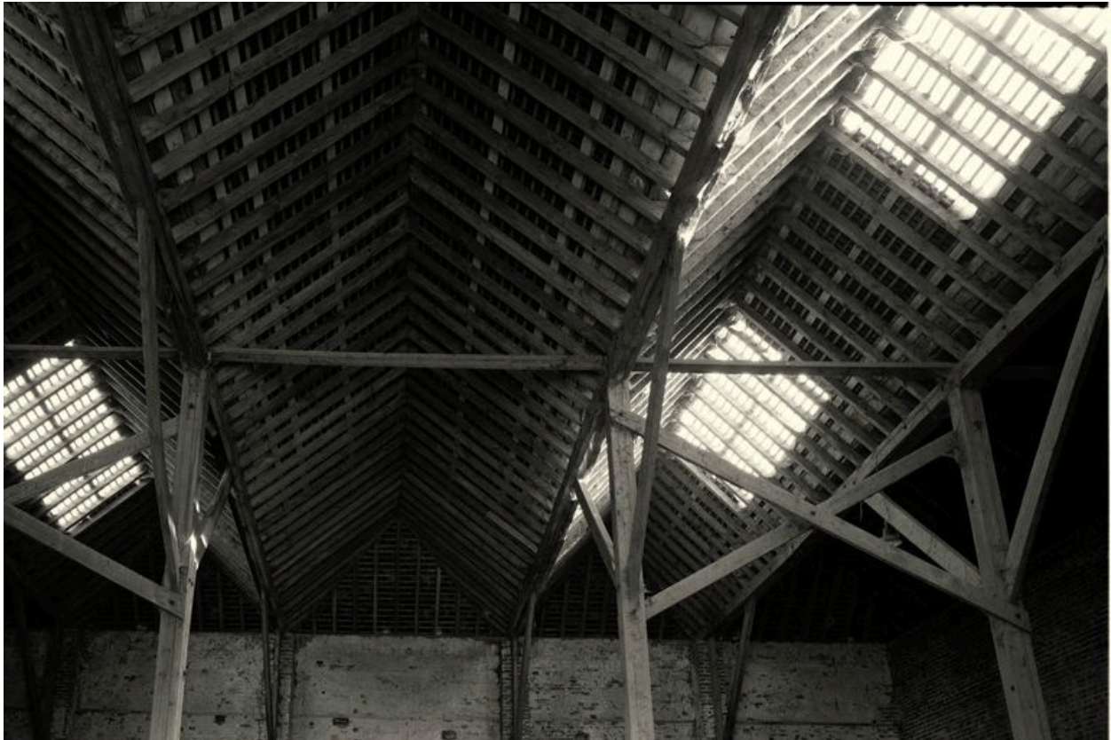
Charpente de la grange.
