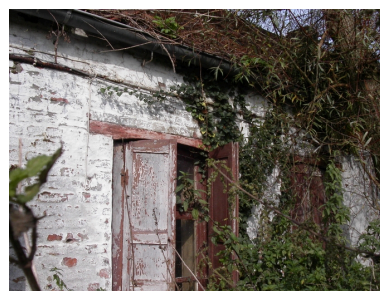
Logis situé 641, rue de la Pulmez, vue depuis la rue : linteau de fenêtre en bois (avec cintre), détail du logis (à l'abandon). Phot. Cyril Cailleau IVR31_20055907505NUCA
