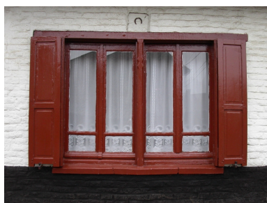
Logis situé 141, rue de Guivarmez, détail du châssis à meneau en bois.
