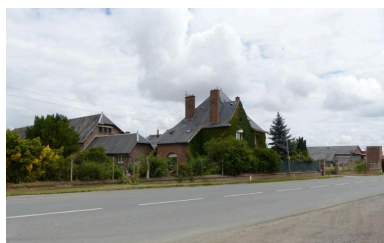
Vue de situation, depuis le sud-ouest. Phot. Isabelle Barbedor IVR32_20208005250NUCA
