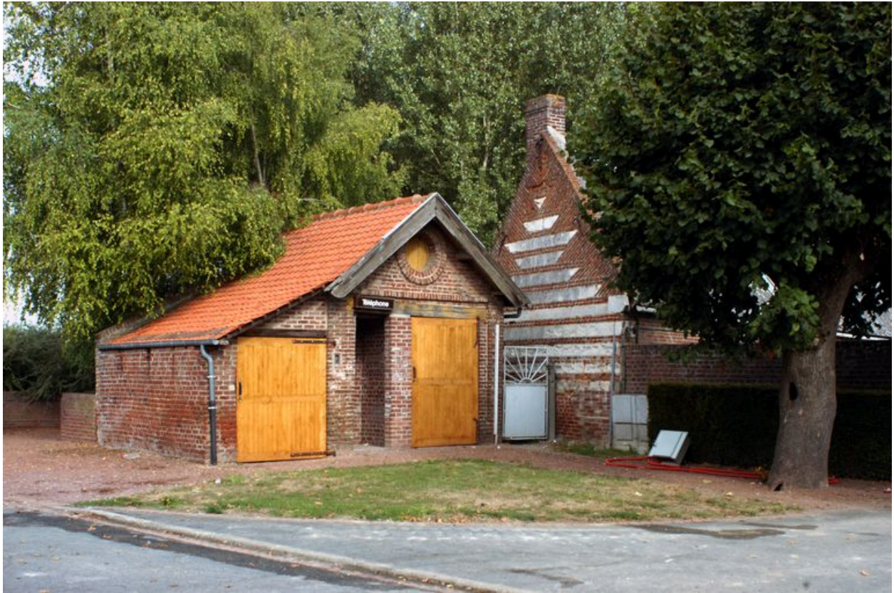
Vue du pignon sud du corps de logis.
