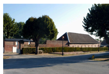
Dépendances agricoles fermant la cour au sud. Phot. Thierry Lefébure IVR22_20038000949NUCA
