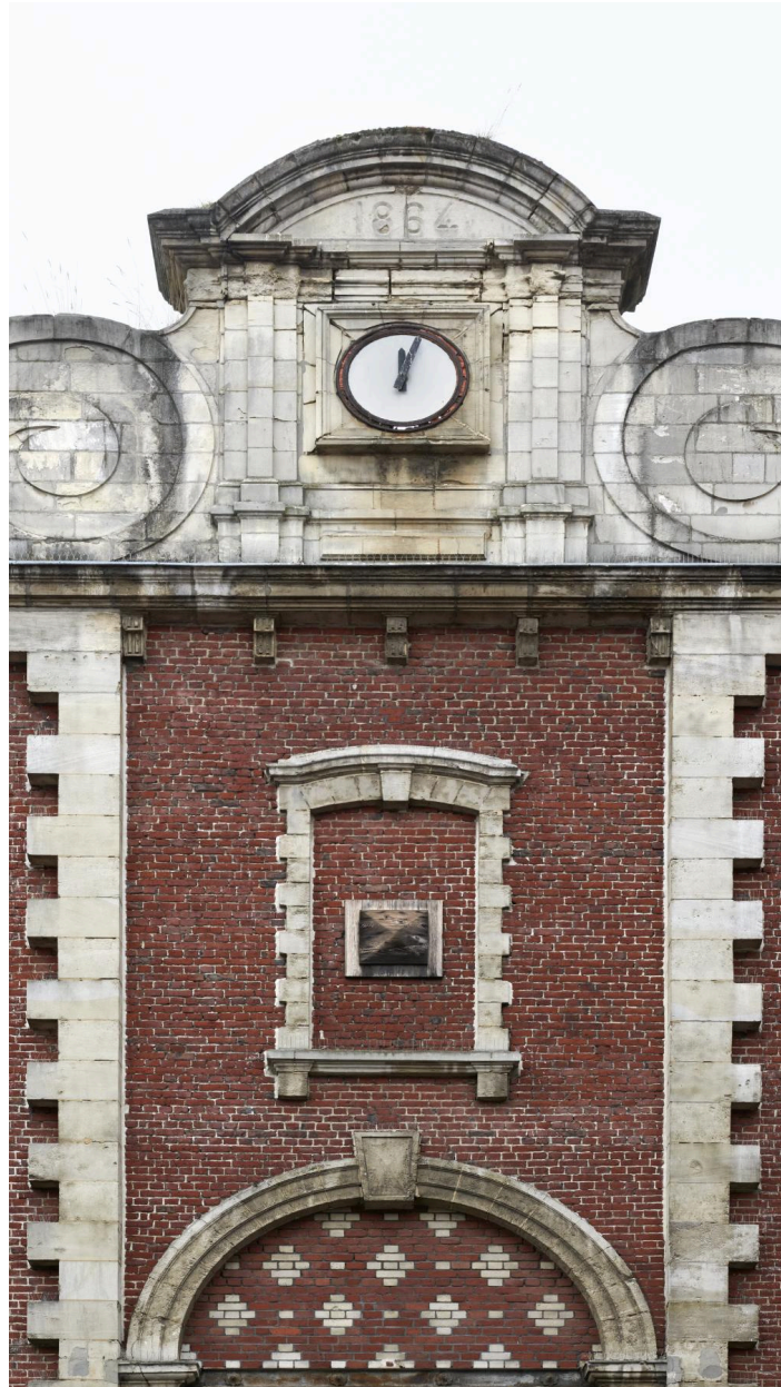
Façade ancienne, pignon à volutes avec fronton semi-circulaire au centre, tympan décoratif de la porte centrale, détail.
