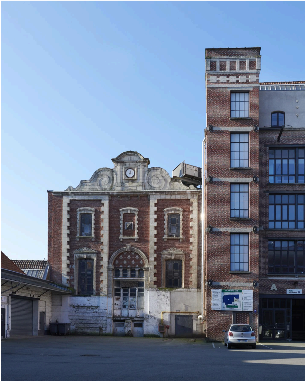
Façade nord et tour donnant sur la cour intérieure.
