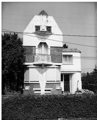
Vue générale de l'élévation antérieure.
