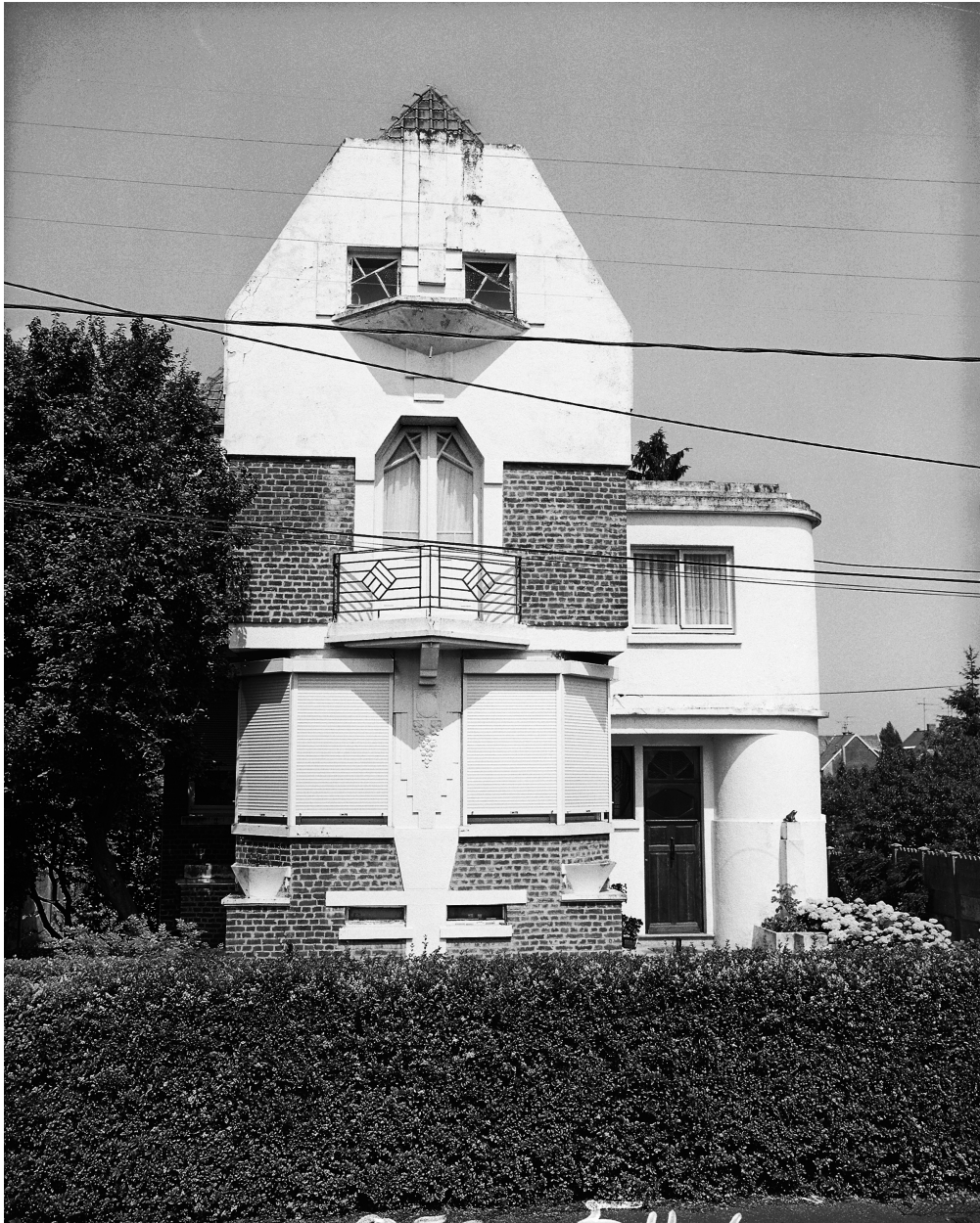
Vue générale de l'élévation antérieure.
