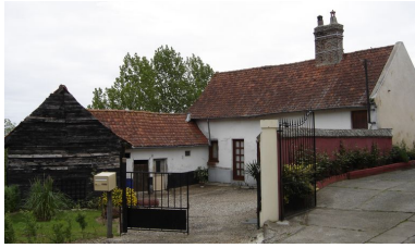
Vue générale. Phot. Inès Guérin IVR22_20058005750NUCA
