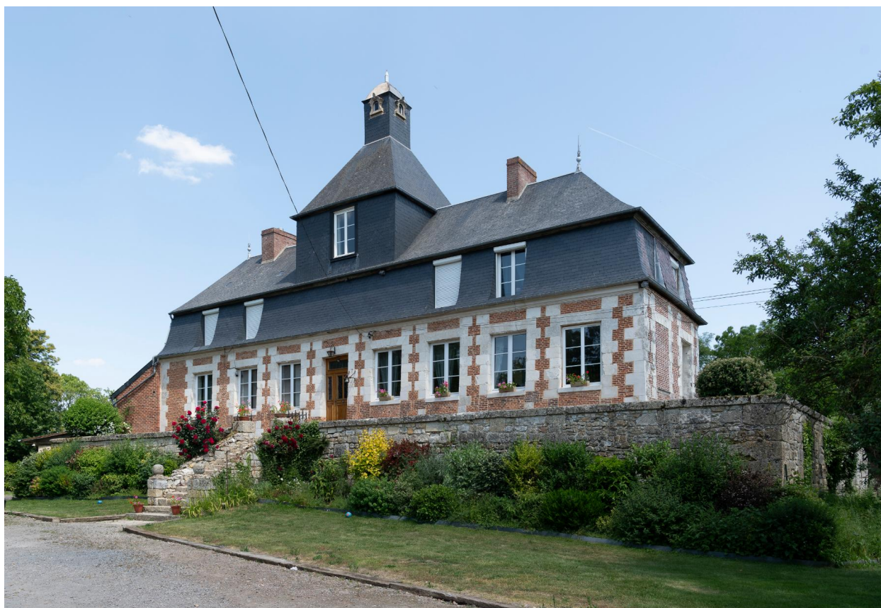
Logis, vue prise depuis le sud-ouest.
