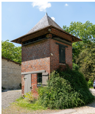
Pigeonnier, vue prise depuis le sud.
