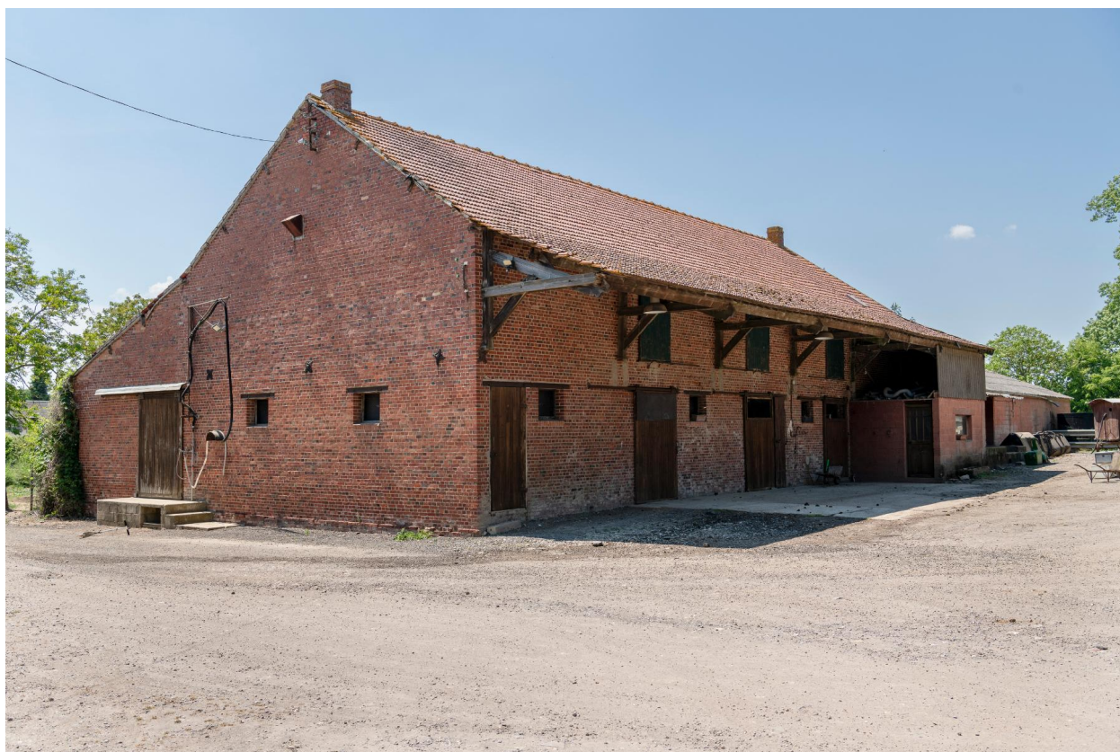
Vue des écuries prise depuis l'est.
