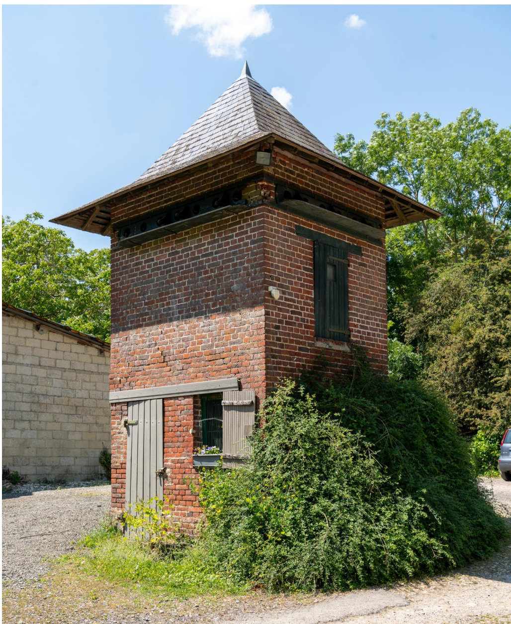
Pigeonnier, vue prise depuis le sud.
