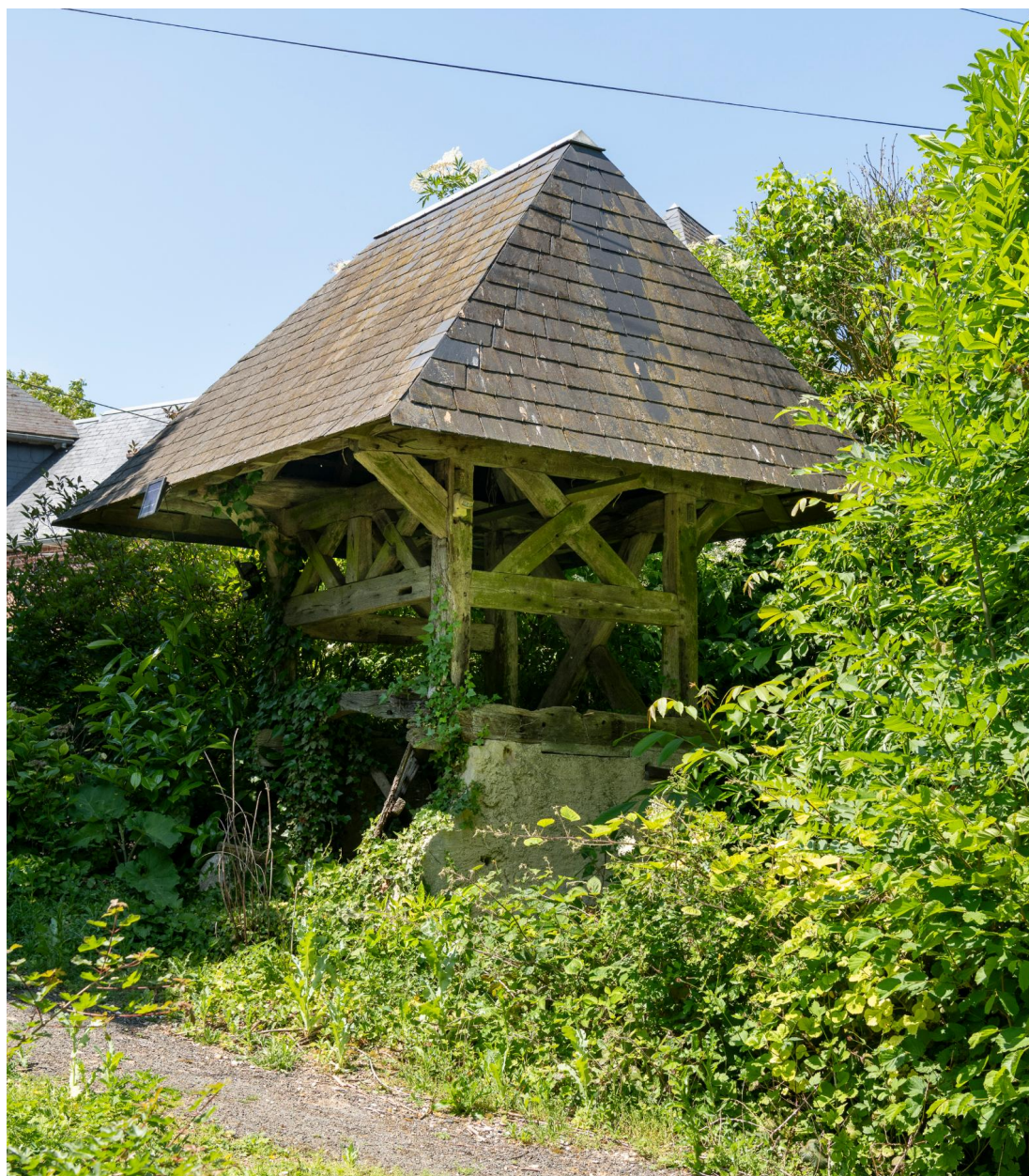
Puits, vue prise depuis le sud-est.
