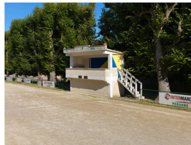
La tribune, vue du sud. Phot. Thierry Lefébure IVR32_20218000267NUCA
