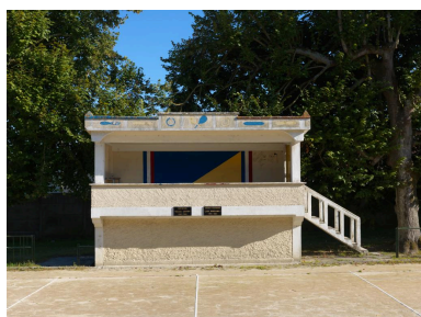
La tribune, vue de face. Phot. Thierry Lefébure IVR32_20218000268NUCA
