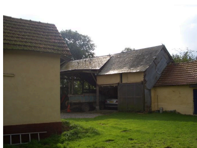
Vue du hangar en fond de propriété. Phot. Inès Guérin IVR22_20078005266NUCA
