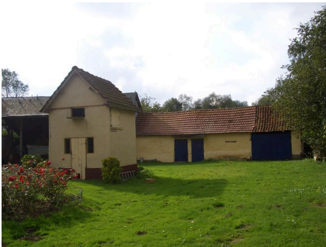
Vue du pigeonnier en milieu de cour et des bâtiments agricoles en fond de cour.
