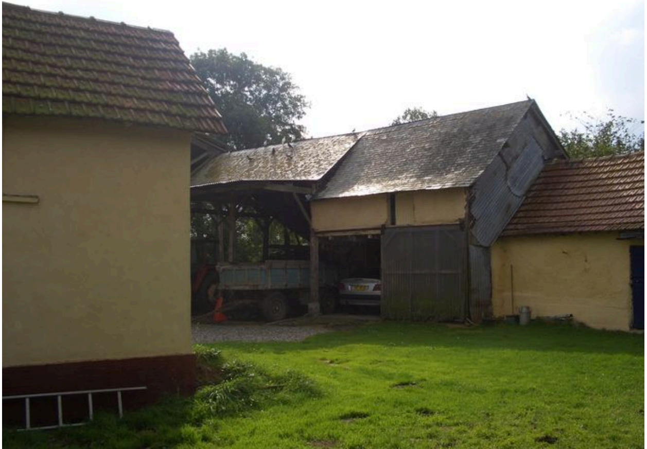
Vue du hangar en fond de propriété.
