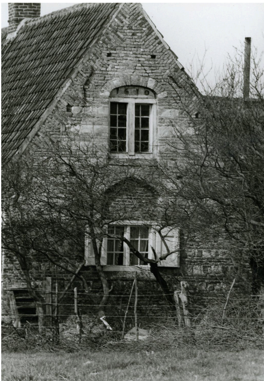
Détail des deux baies du pignon est, 1975 (coll. Comité Flamand de France).
