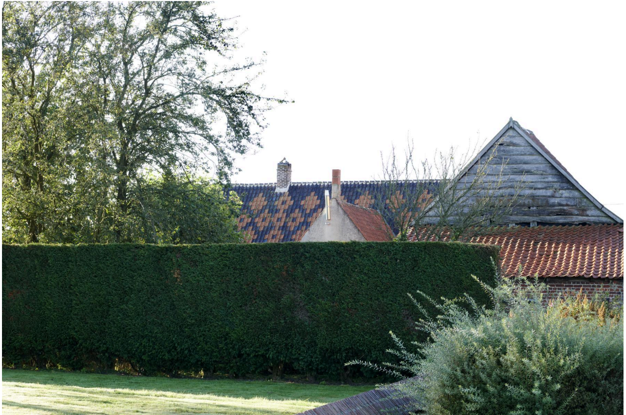
Détail de la couverture en pannes flamandes sur le versant nord de la toiture.
