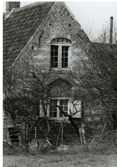
Détail des deux baies du pignon est, 1975 (coll. Comité Flamand de France). Repro. Delphine Volto Jourdan IVR32_20255900336NUCAB
