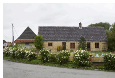
Façade sud, donnant sur le carrefour. Phot. Delphine Volto Jourdan IVR32_20245902961NUCA
