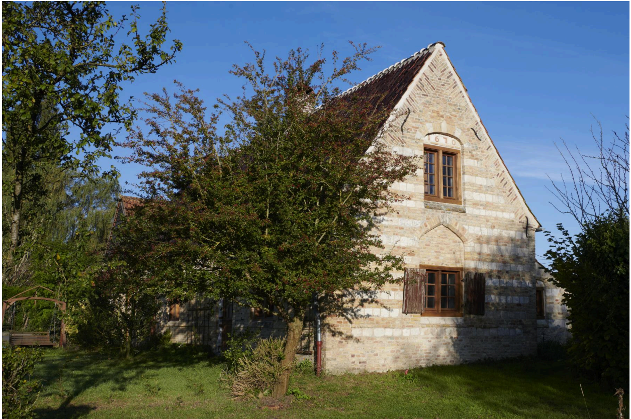
Vue générale du pignon situé à l'est.
