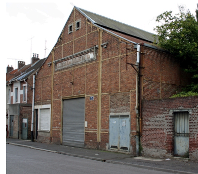
L'atelier construit en 1922. Phot. Frédéric Pillet IVR22_20040200900NUCA
