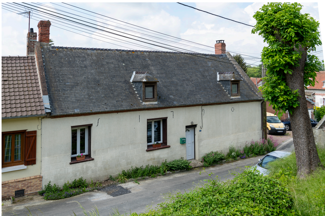
Logis sur rue avec date portée "1790", n°6 de la rue de la Chapelle, vue depuis le nord.
