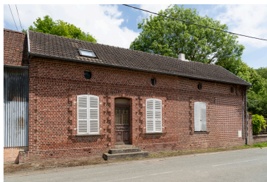
Logis sur rue, n°13 de la rue d'En- Bas, vue depuis le sud-ouest. Phot. Marc Kérignard IVR32_20246000473NUCA
