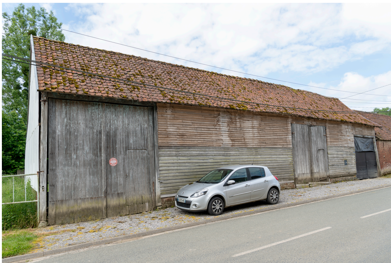
Grange sur rue et entrée charretière, n°2 de la rue d'En-Bas, vue depuis le nord.
