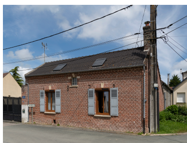
Logis en brique avec date portée "1873", n°2 de la rue d'En-Haut, vue depuis le sud. Phot. Marc Kérignard IVR32_20246000469NUCA
