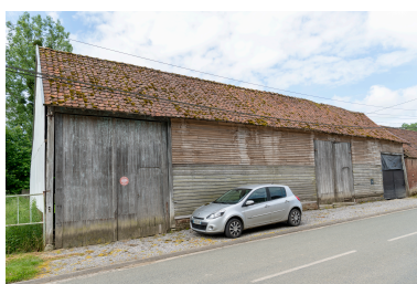
Grange sur rue et entrée charretière, n°2 de la rue d'En-Bas, vue depuis le nord. Phot. Marc Kérignard IVR32_20246000465NUCA
