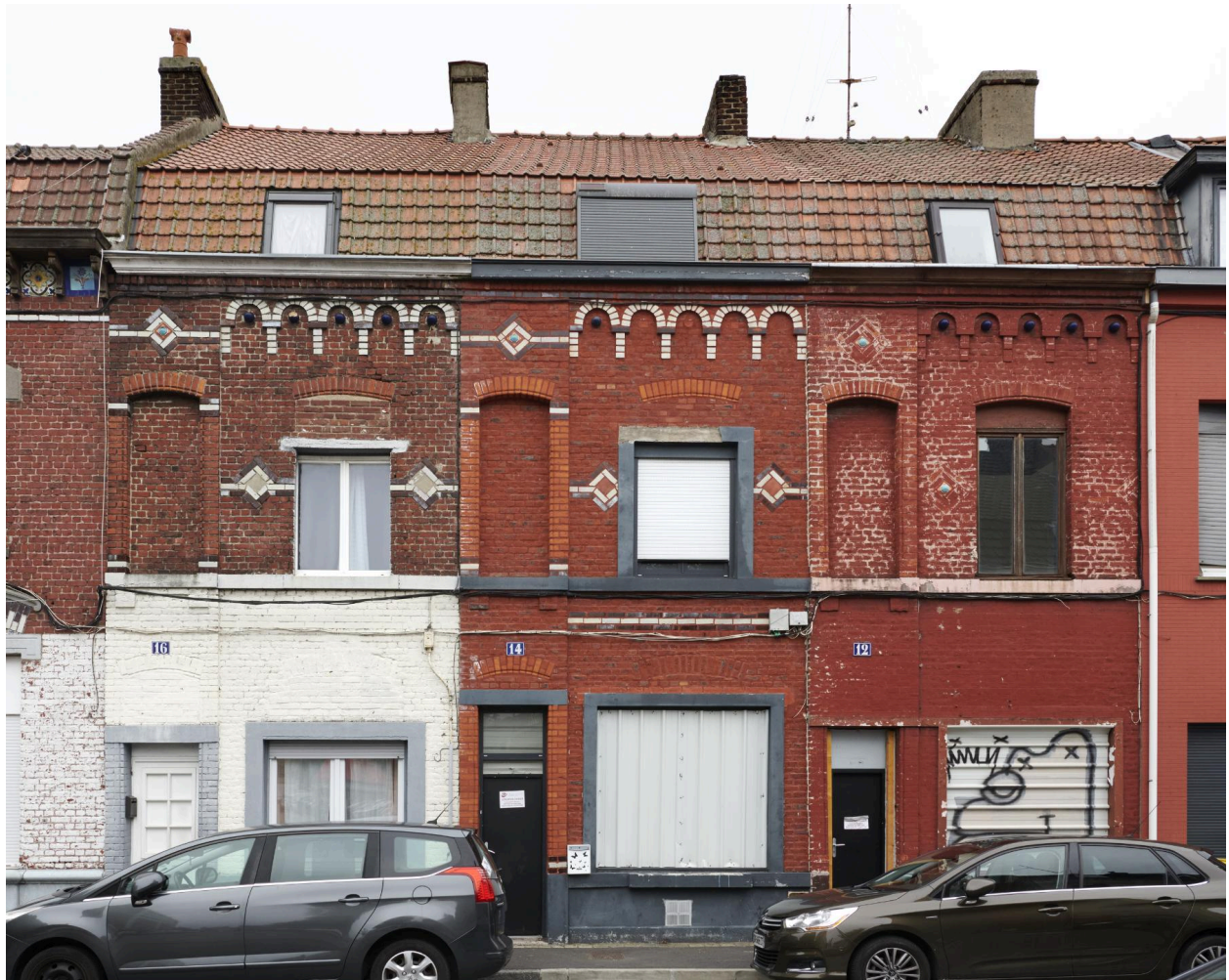
Vue des façades 12-14-16 rue des Ogiers.
