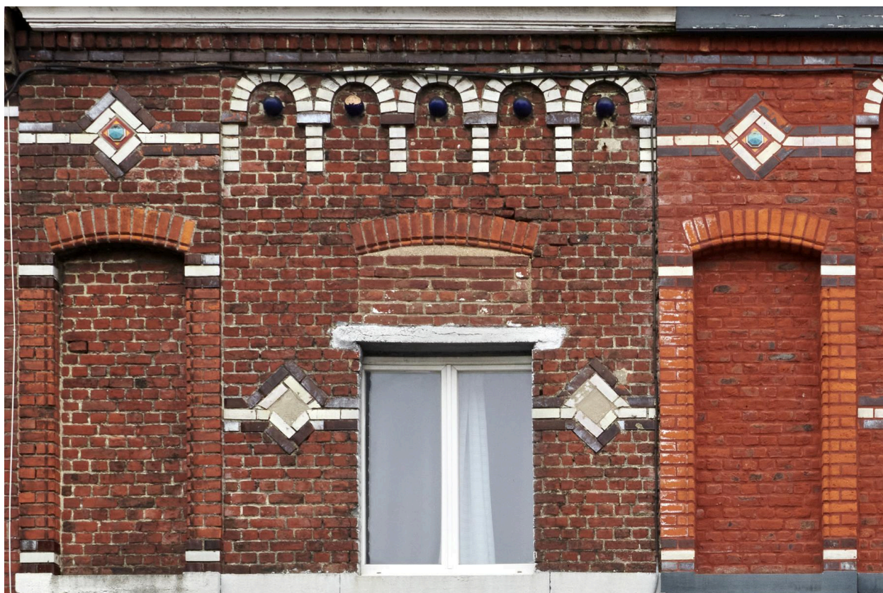
Décor 16 rue des Ogiers : motifs et frises de petites arcades en brique blanche entourant un cabochon en terre cuite vernissée. Détail.
