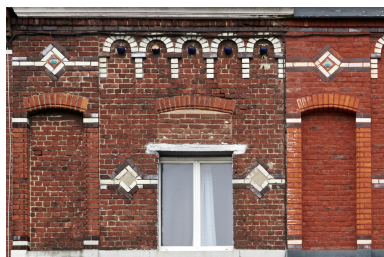
Décor 16 rue des Ogiers : motifs et frises de petites arcades en brique blanche entourant un cabochon en terre cuite vernissée. Détail. Phot. Delphine Volto Jourdan IVR32_20265900064NUCA
