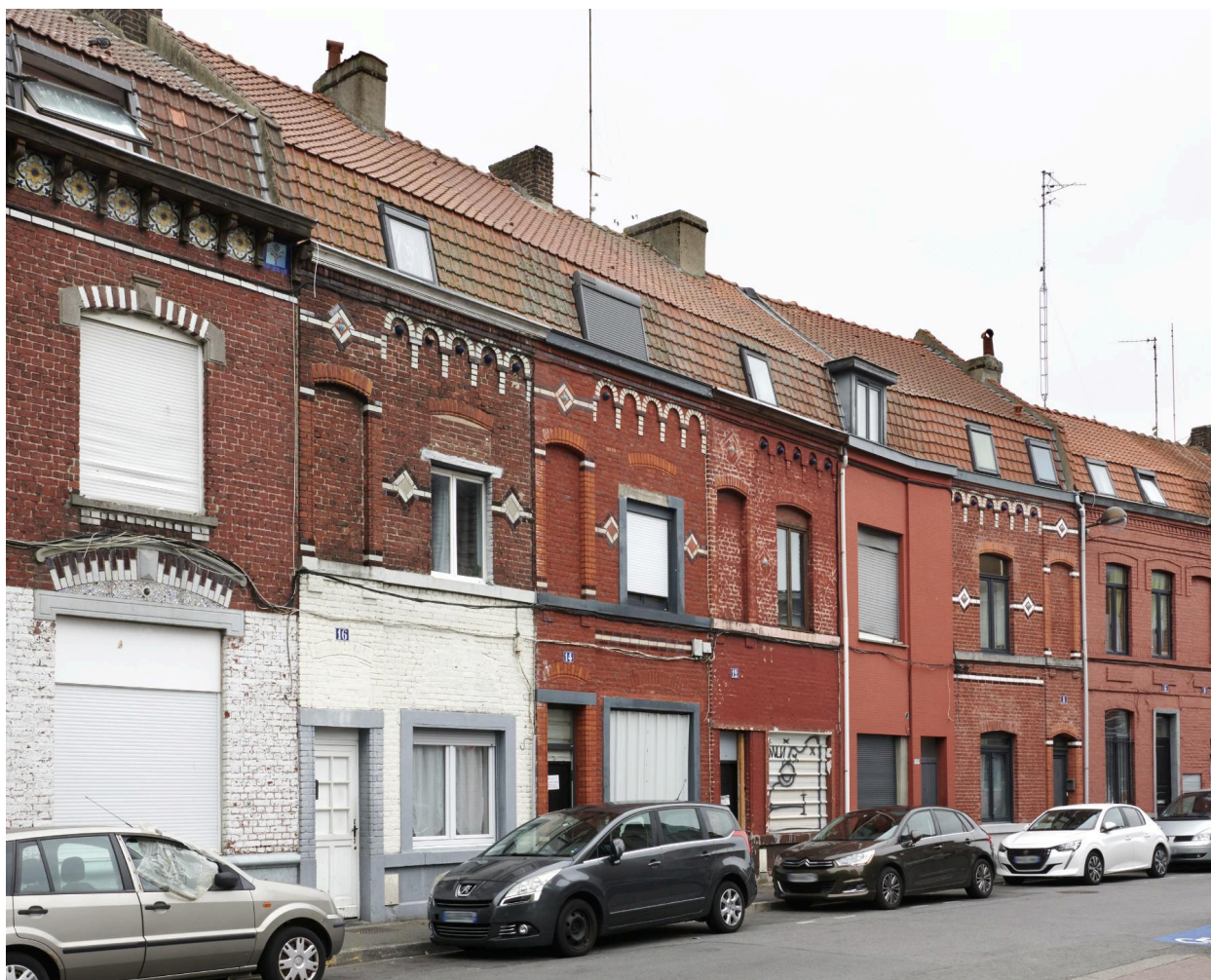
Vue générale du rang : façades.
