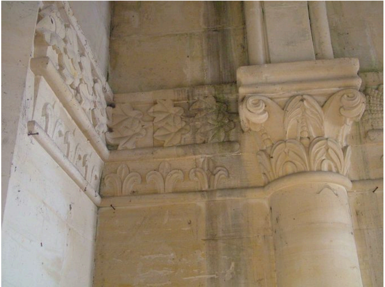
Vue d'un chapiteau et de la frise dans la chapelle.
