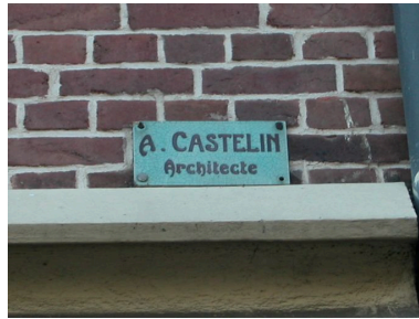
Détail du carreau de céramique portant signature de l'architecte. Phot. Elisabeth Justome IVR22_20058003470NUCA
