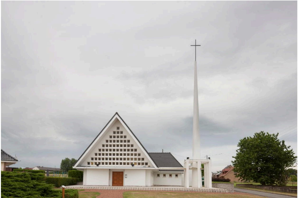
Vue générale vers le nord-est.
