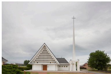
Vue générale vers le nord-est. Phot. Hubert Bouvet IVR32_20156200136NUC4A
