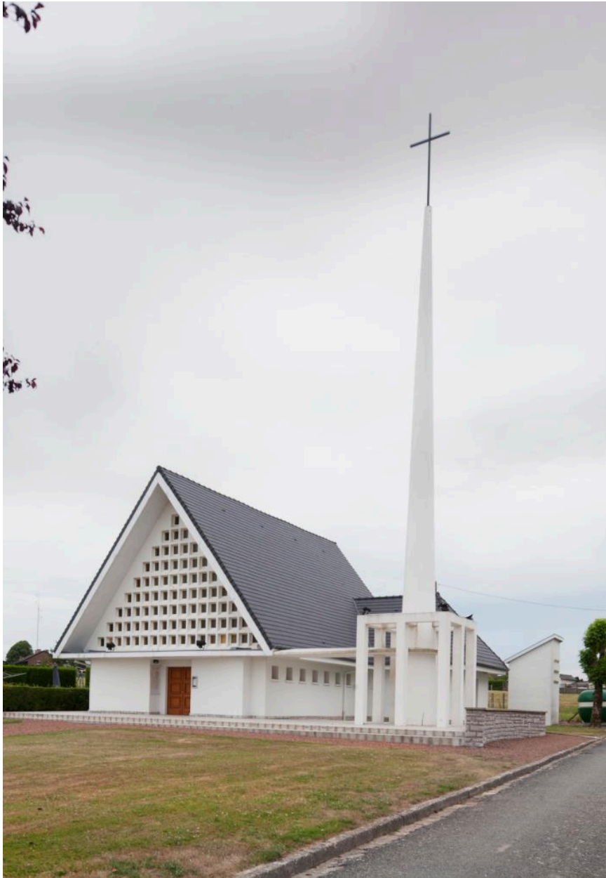
Vue de trois quarts, vers le nord.
