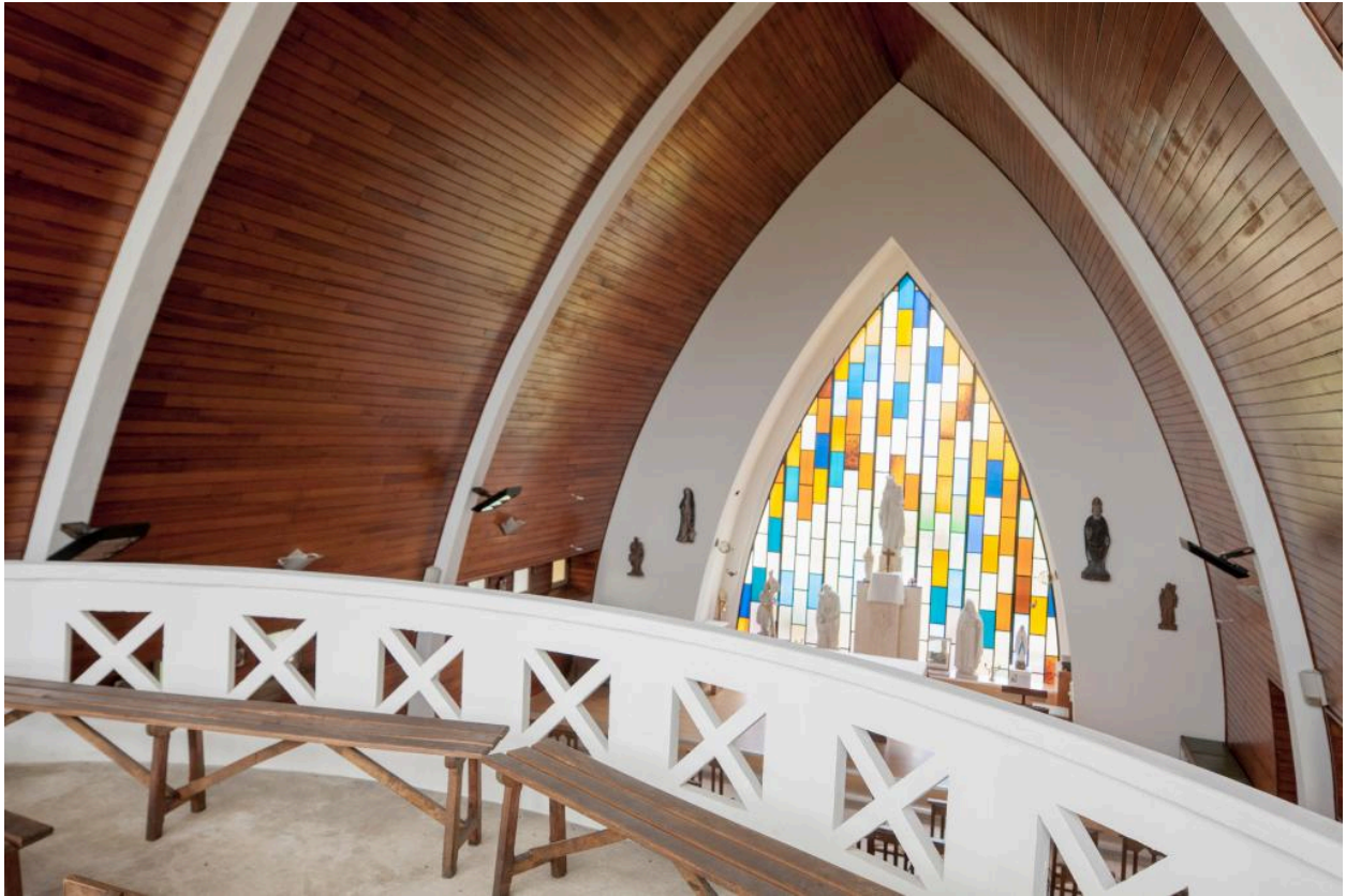
La charpente et la verrière, depuis la tribune.
