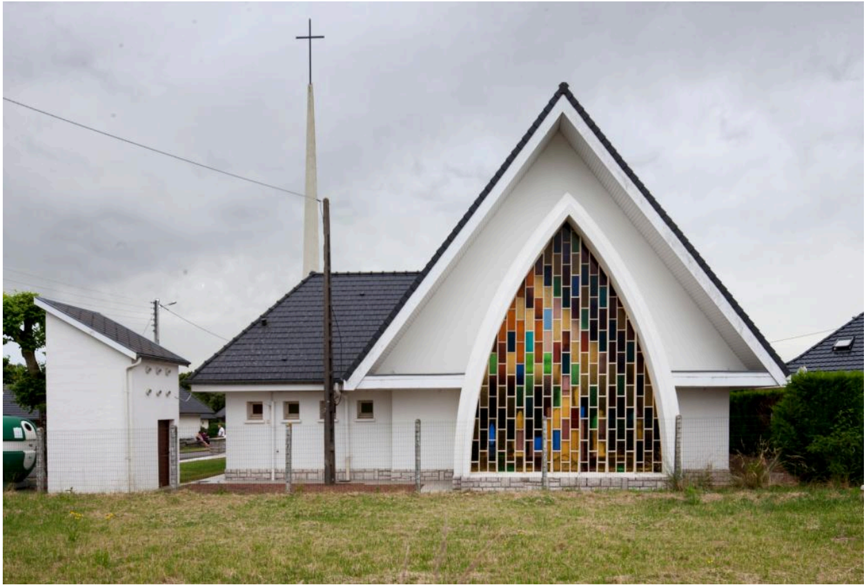
Élévation postérieure, vers l'ouest.
