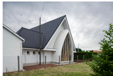
Vue postérieure de trois quarts, vers le nord-ouest. Phot. Hubert Bouvet IVR32_20156200138NUC4A
