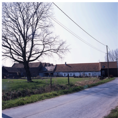
Vue générale de la ferme-usine.
