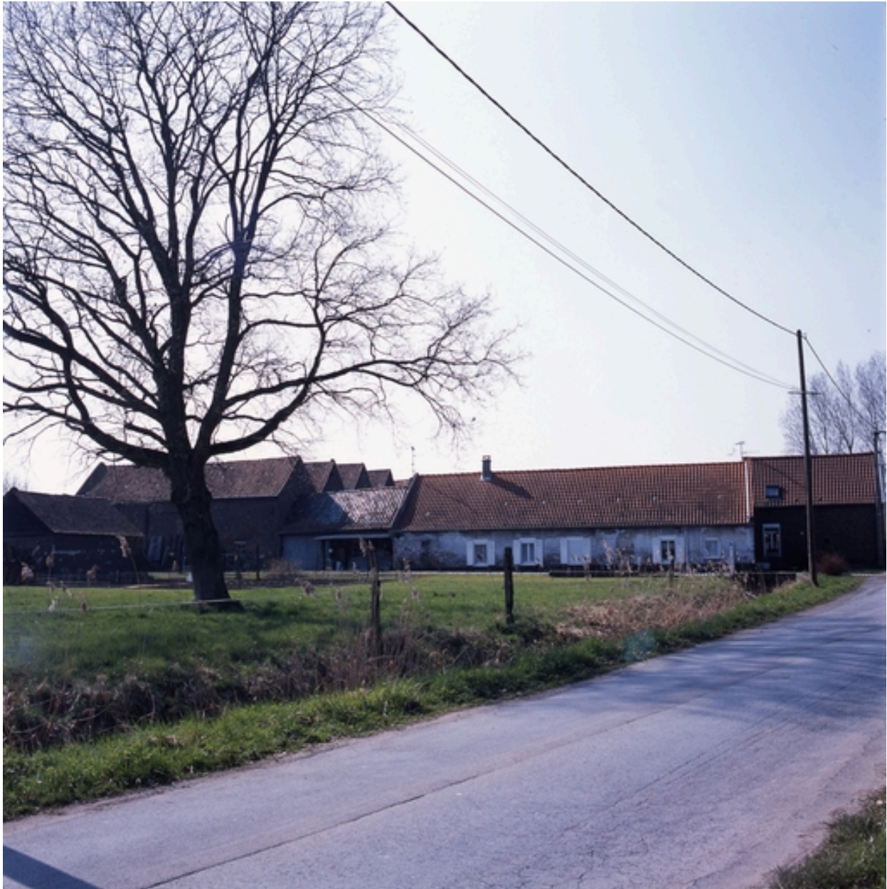
Vue générale de la ferme-usine.
