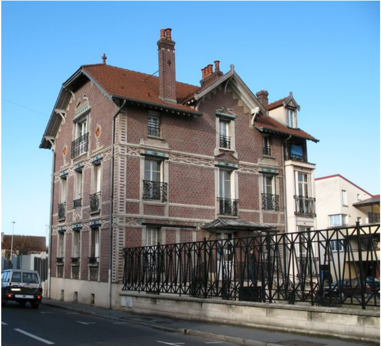
Les bureaux de la brasserie Gryson.
