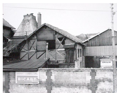
Les ateliers de la brasserie à l'abandon dans les années 1970. Phot. Clarisse Lorieux IVR22_20076005621NUCA
