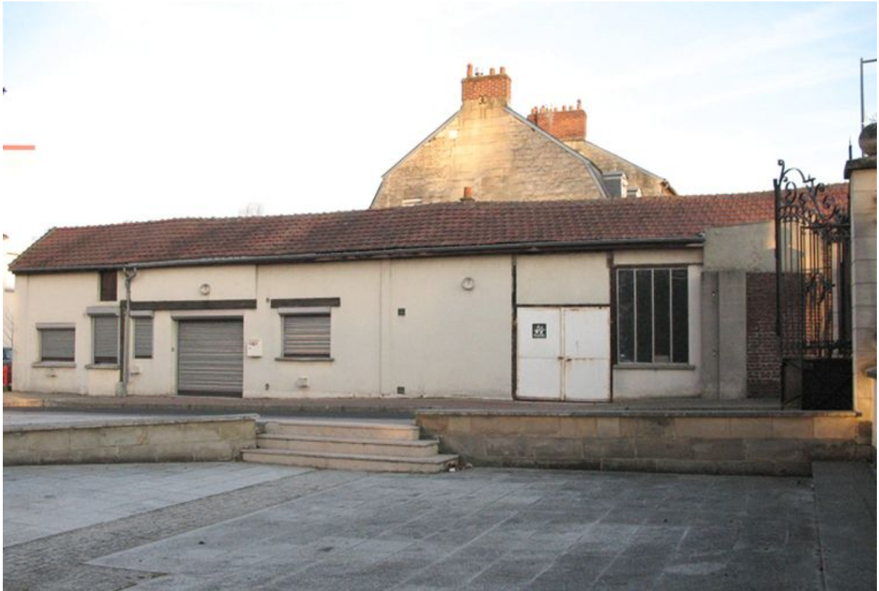
Un atelier de fabrication de la brasserie.
