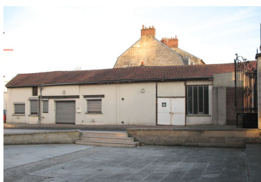
Un atelier de fabrication de la brasserie. Phot. Clarisse Lorieux IVR22_20076005633NUCA
