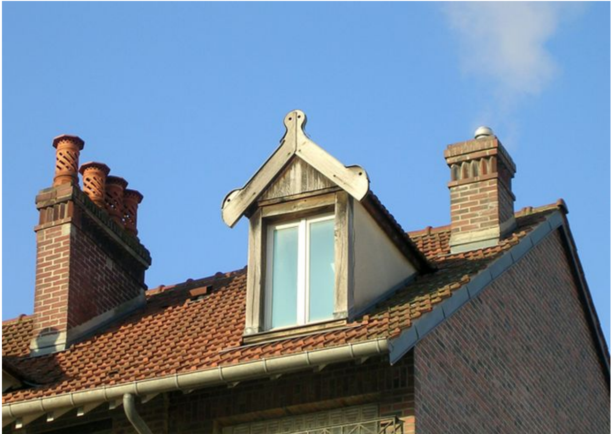
Détail de la toiture.
