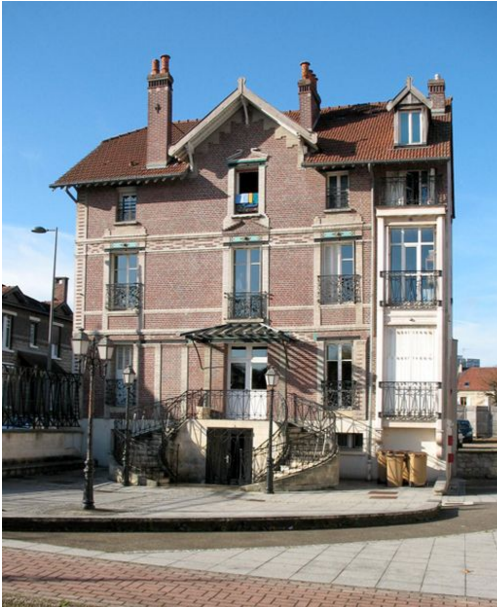
Façade est de la brasserie Gryson.
