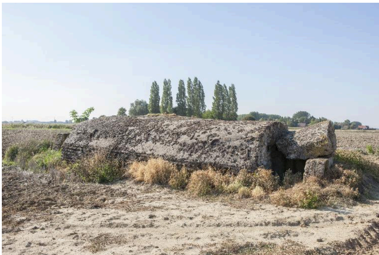
Vue générale vers le nord-ouest
