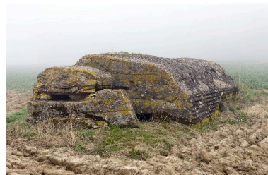
Vue de trois-quarts vers le nord-est. Au premier plan une des deux entrées pare-souffle. Phot. Pierre Thibaut IVR31_20145905443NUCA
