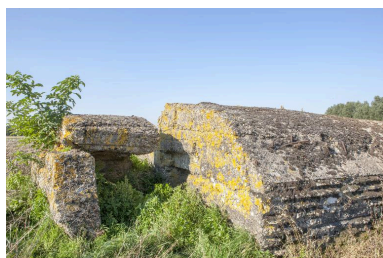
Dispositif pare-souffle de l'entrée ouest Phot. Pierre Thibaut IVR31_20155901699NUCA
