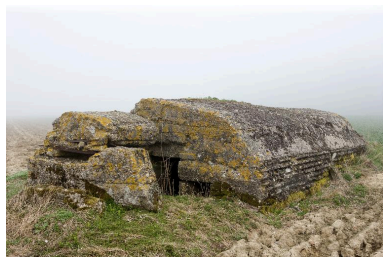
Vue de trois-quarts vers le nord-est. Au premier plan une des deux entrées pare-souffle. Phot. Pierre Thibaut IVR31_20145905442NUCA
