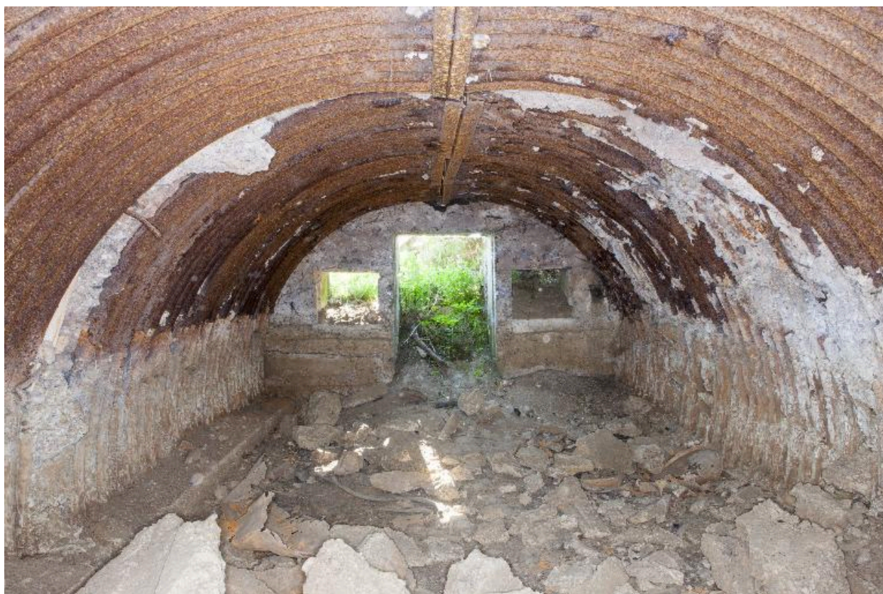
Vue intérieure, vers le sud-ouest
