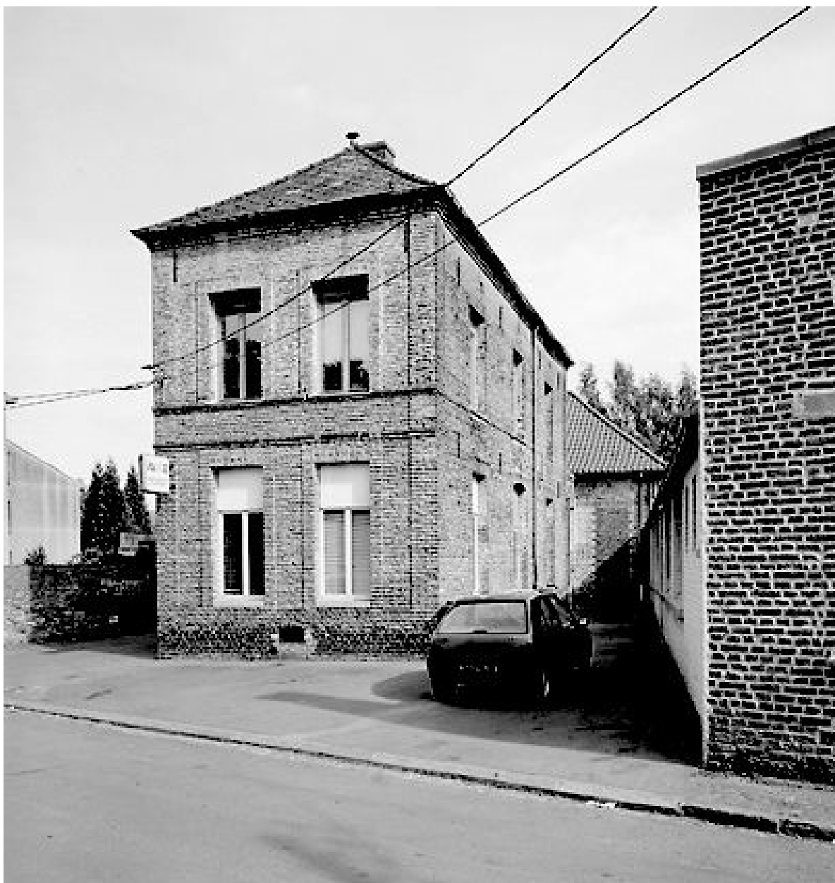
Vue générale ; en premier plan, la maison de la directrice, derrière laquelle s'élève la salle d'asile.
